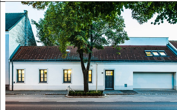
Bild 16: Beispiel Umnutzung zu einem Einfamilien-Wohnhaus, Quelle: http://www.bauer-arch.at/projekte/
