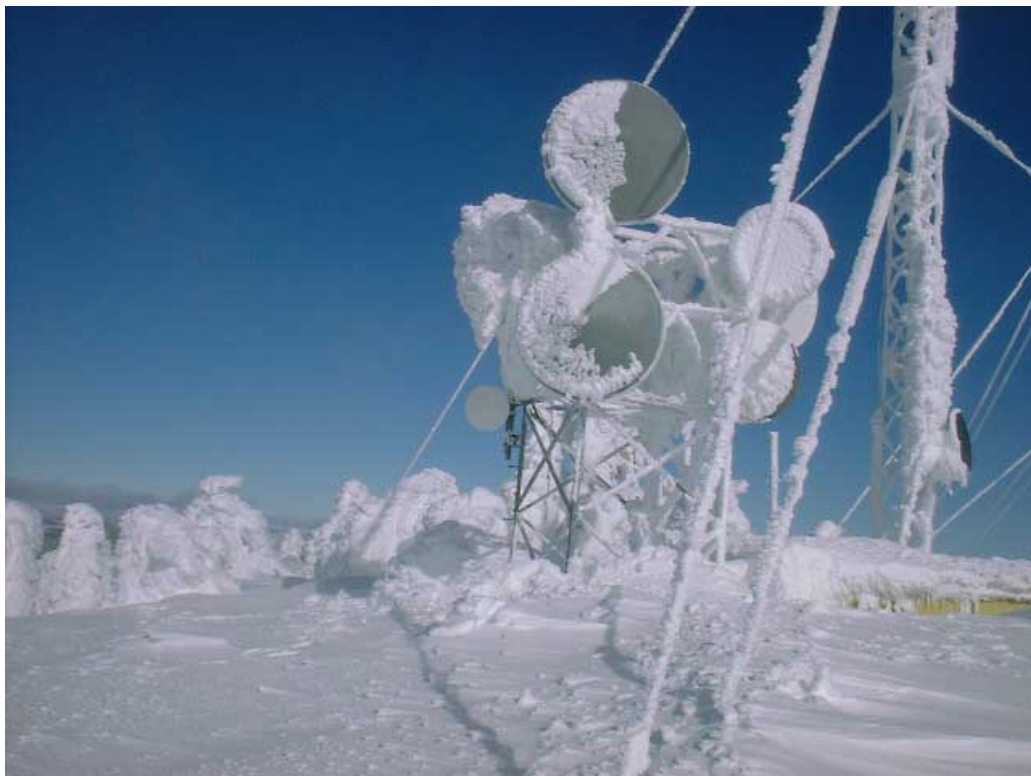
2-15. Abb. Maste unter Eislast - [25]
