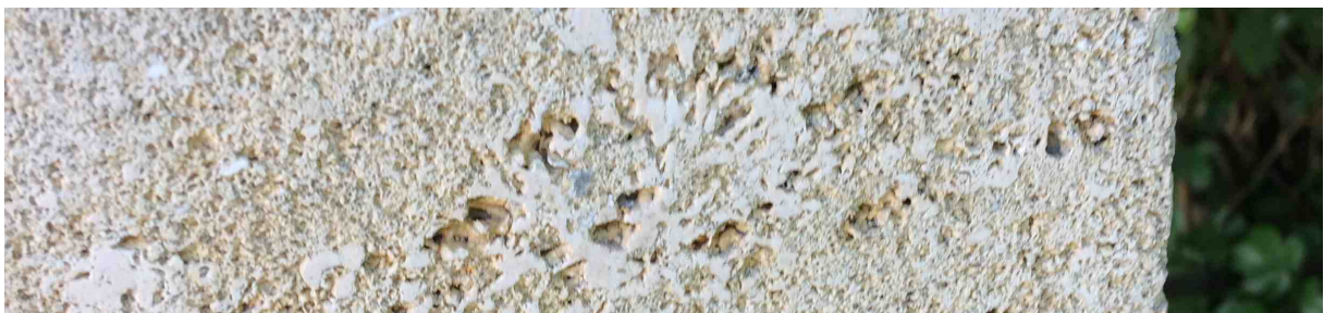
Abb. 22 Grob-poröser Bereich (eingeschlossene Algenkolonie) beim St. Margarethener Kalksandstein
