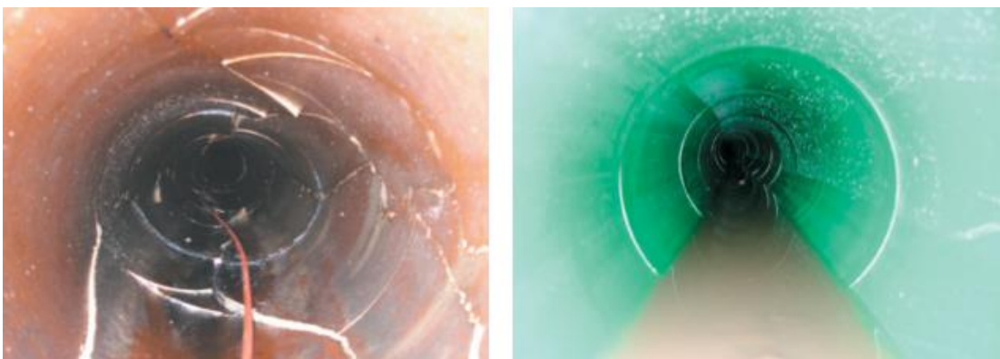
Abbildung 44: Relining eines Abwasserkanals aus Steinzeug anhand Kurzrohrlining bzw. Tight in Pipe - Verfahren mit einem PP-Neurohr. Links im Bild wird der Zustand vor der Sanierung gezeigt und rechts im Bild der Zustand nach der Anwendung des Verfahrens [18].
