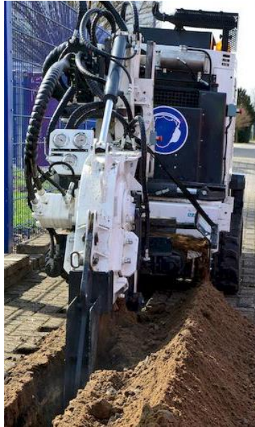
Abbildung 24: Verlegung eines Glasfaserkabels mittels Herstellung von Schlitzgräben [106].
