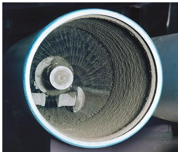
Abbildung 13: Beschichtungsverfahren unter Verwendung von Zementmörtel [75].
