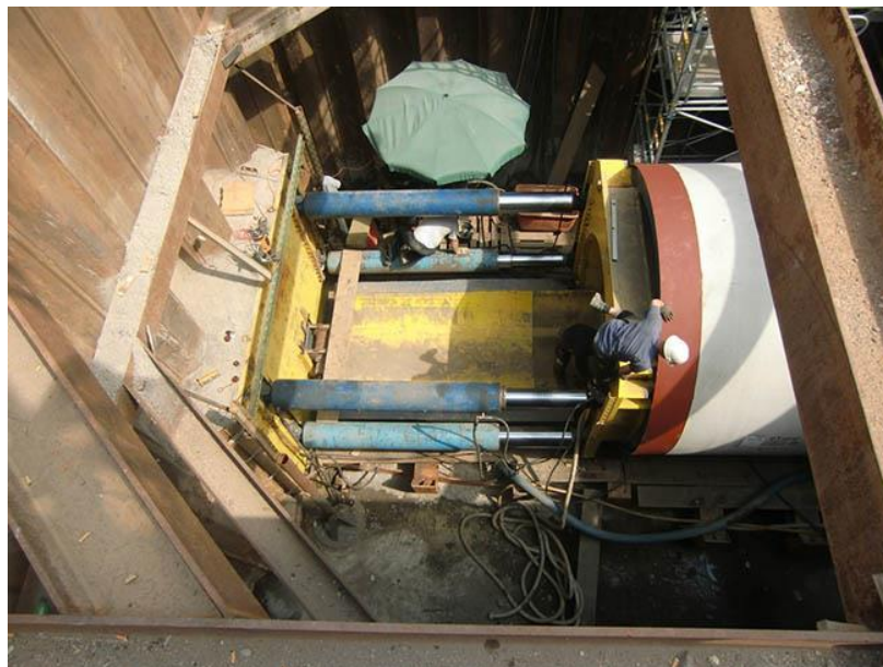
Abbildung 40: Startschacht des Vortriebs von Stahlbetonrohren [9].
