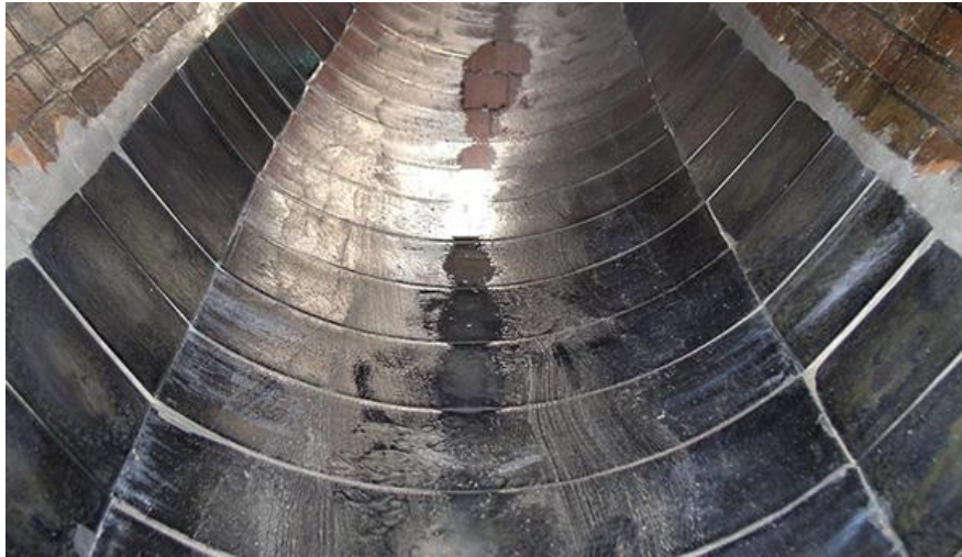
Abbildung 16: Erneuerter Kanal durch im unteren Bereich aufgebrachter Rohrsegmente [93].
