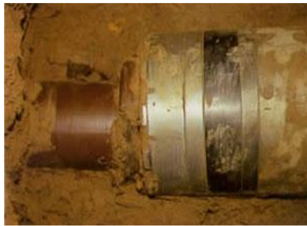
Abbildung 45: Überfahren eines Altrohres aus Steinzeug [6].
