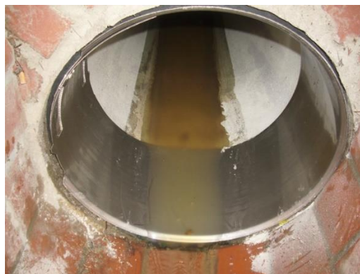
Abbildung 21: Repariertes Kanalstück aus Steinzeug mithilfe von Edelstahlmanschetten [68].
