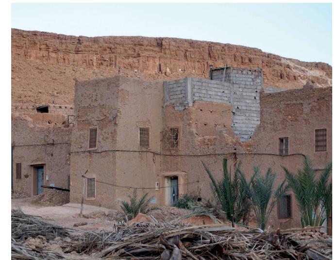
Abb.58: Lehmbau wird durch Stahlbeton ersetzt
