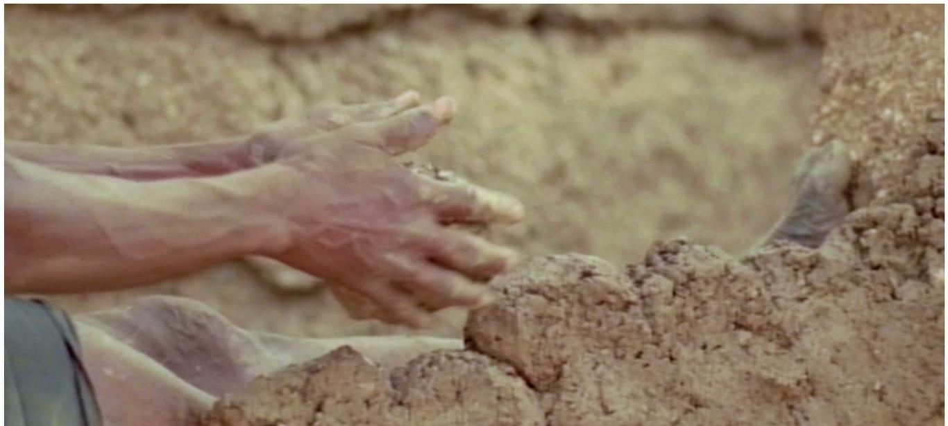
Abb.95: Nasslehmtechnik der Batammariba
