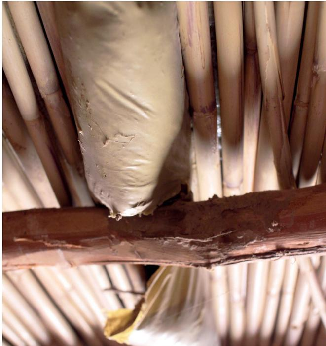
Abb.33: Deckenaufbau mit Plastikfolie
