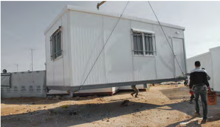
Abb. 40: Aufstellung der Wohncontainer
