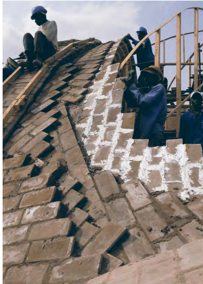
Abb. 28: Konstruktion des Gewölbes
