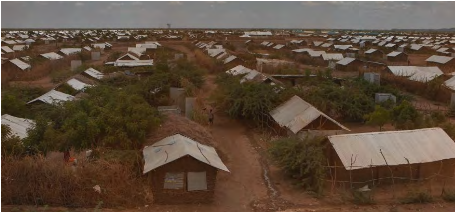
Abb. 45: Einraumhütten aus Lehm und dünnen Hölzern im Flüchtlingscamp
