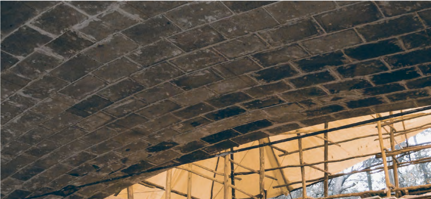
Abb. 34: Konstruktion des Gewölbes mit Zementkacheln
