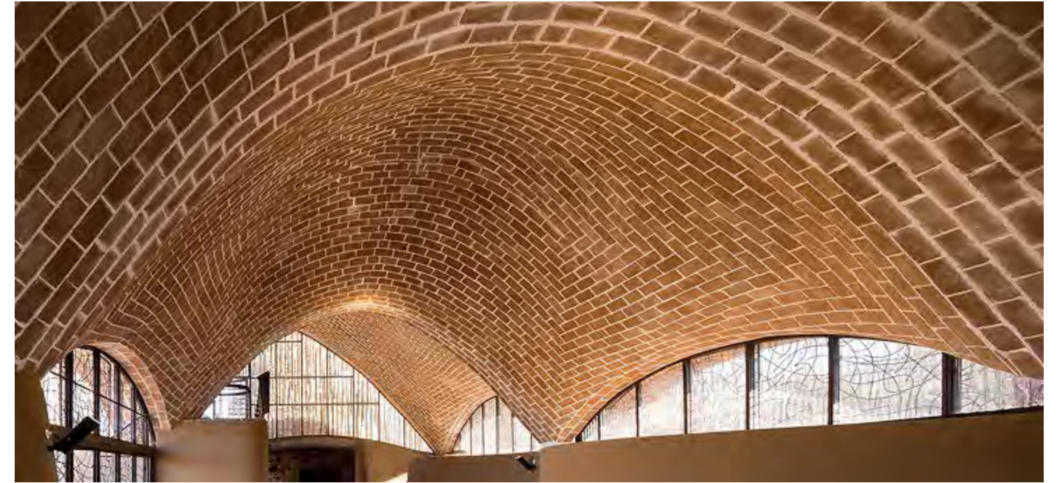
Abb. 30: Ansicht des Gewölbes vom Innenraum
