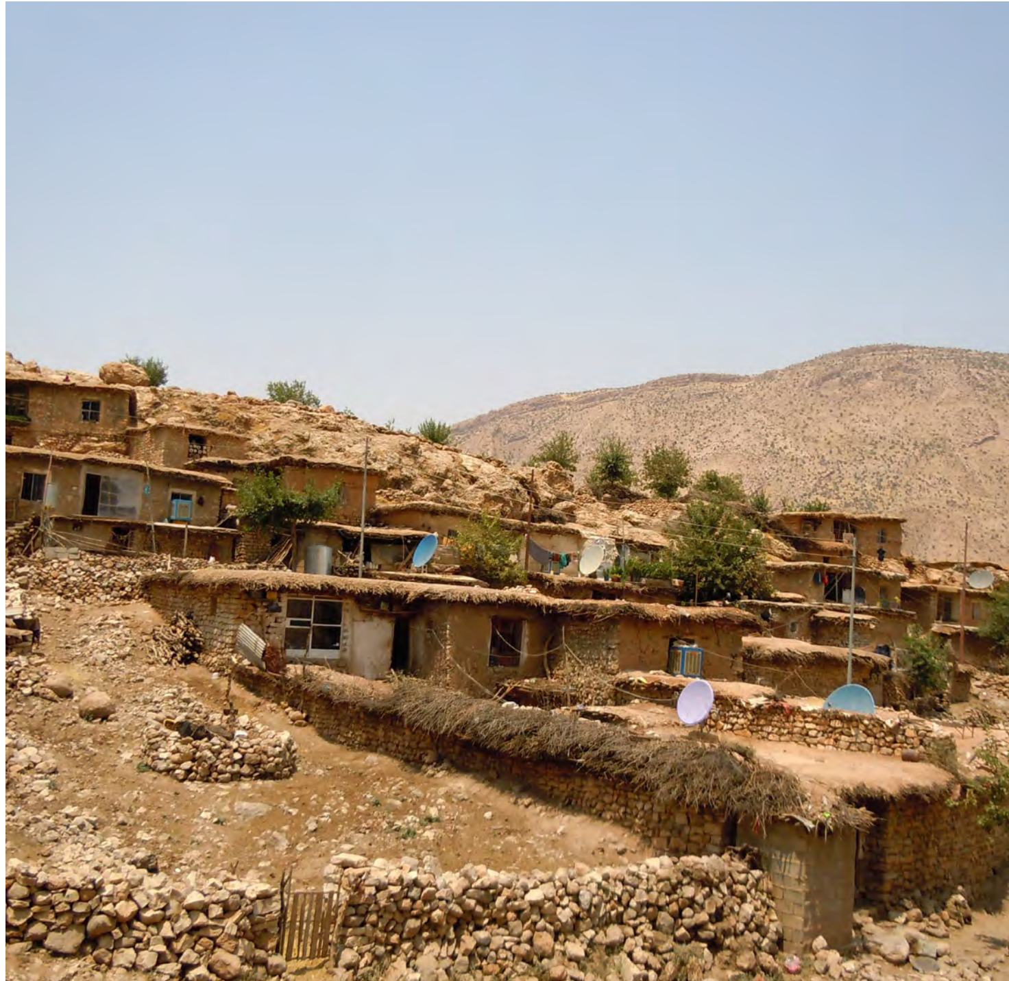
Abb. 23: Lehmhütten in Lehmziegelbauweise
