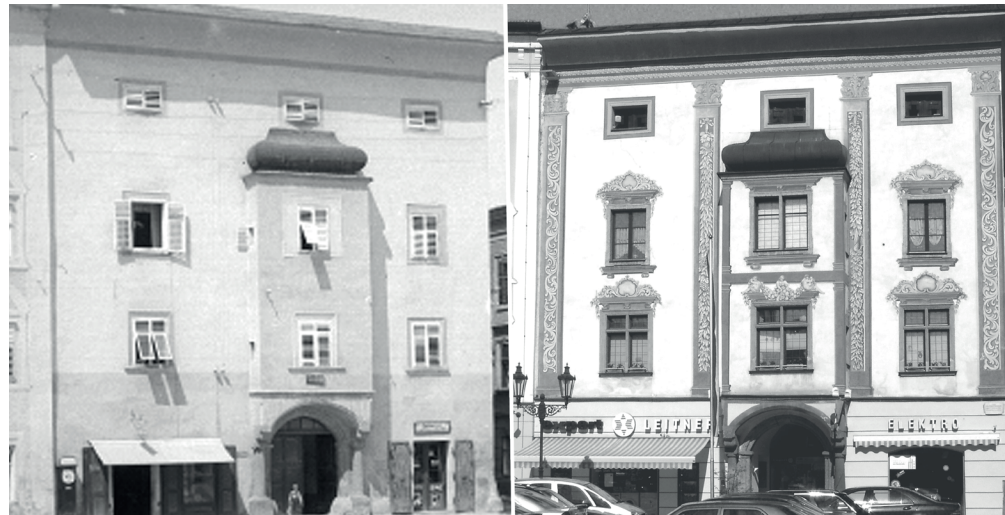
Abb. 3.9: Hauptplatz 7, Zustand 1929 — Zustand heute. Die ornamentale Seccomalerei wurde erst im 20. Jh. appliziert.
