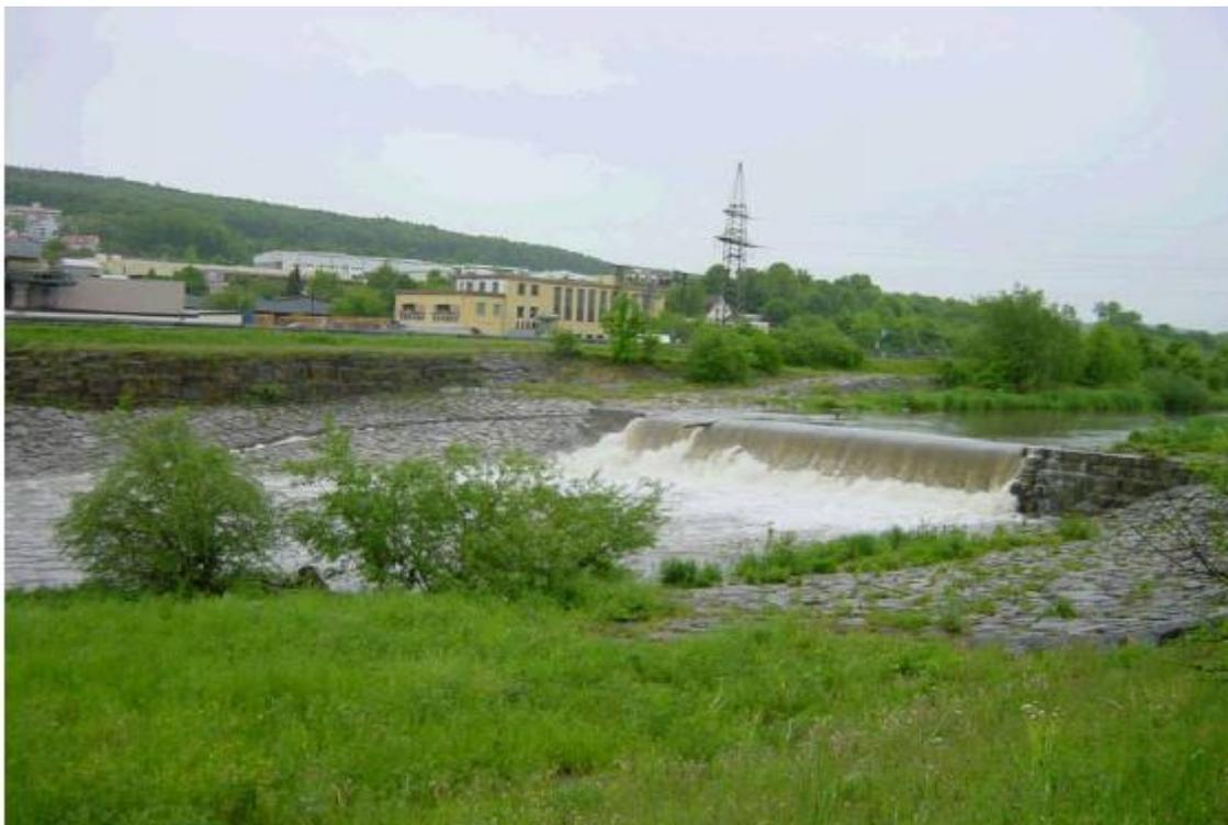
*Abb 3.6.1.1.1: Vorhandene Wehranlage vor dem Bau der neuen konventionellen WKA*
