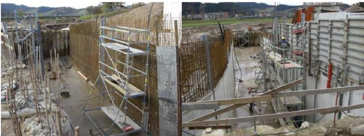
*Abb 5.1.7: Stahlarmierung und geschaltes Betonieren der Seitenwände (Quelle:Abschlussbericht über die Projektstätigkeit vom 01.10.2006 bis zum 30.06.2011, S.22)*
