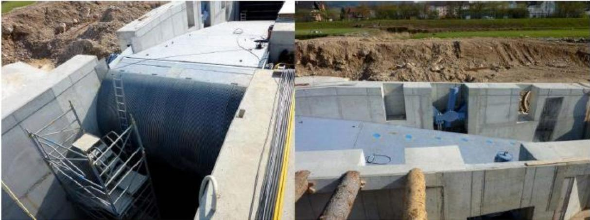
*Abb 5.1.10:Montage Fischrechen und Hydraulikzylinder (Quelle:Abschlussbericht über die Projektstätigkeit vom 01.10.2006 bis zum 30.06.2011, S.23)*
