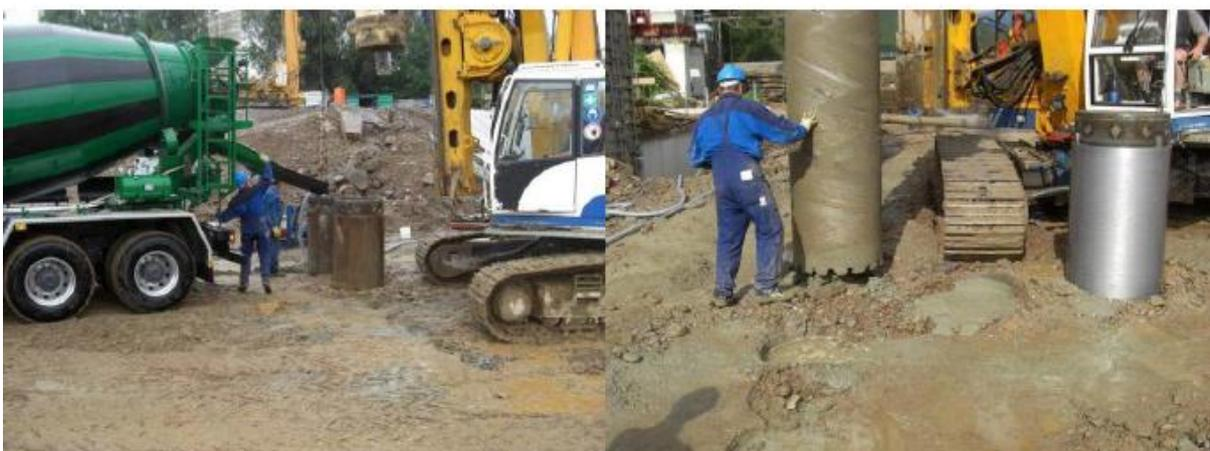
*Abb 5.1.4: Betonierung der Betonpfähle (Quelle:Abschlussbericht über die Projektstätigkeit vom 01.10.2006 bis zum 30.06.2011, S.21)*
