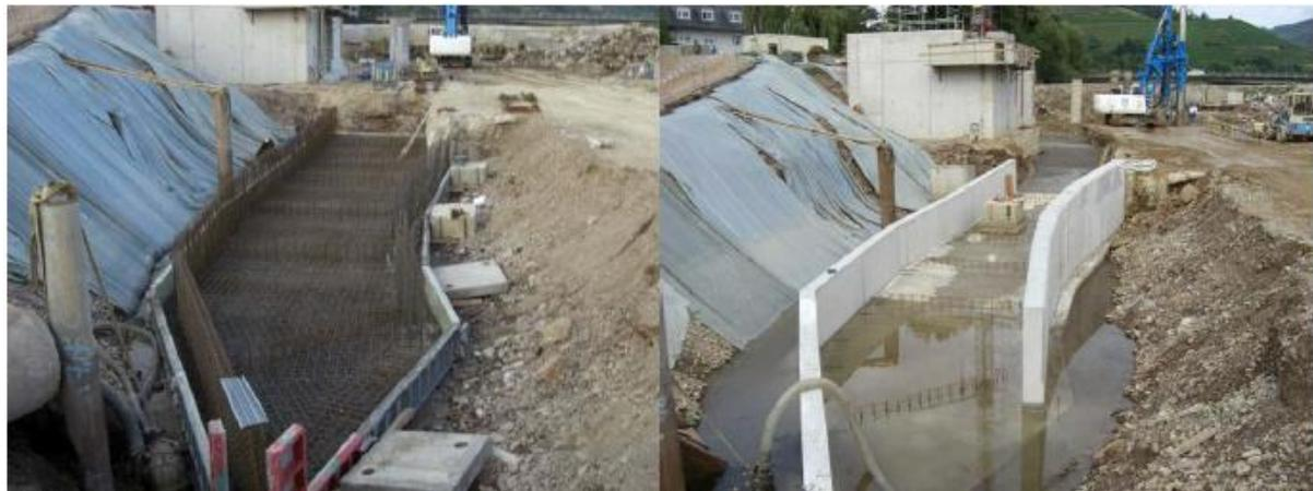
*Abb 5.1.6: Beginn des Baus des Fischpasses, der aufgrund eines Hochwassers geflutet wurde (Quelle:Abschlussbericht über die Projektstätigkeit vom 01.10.2006 bis zum 30.06.2011, S.21)*
