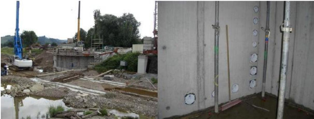
*Abb 5.1.5: Schaltwarte im vielfältigen Duechlässen für die Anschlüsse (Quelle:Abschlussbericht über die Projektstätigkeit vom 01.10.2006 bis zum 30.06.2011, S.21)*
