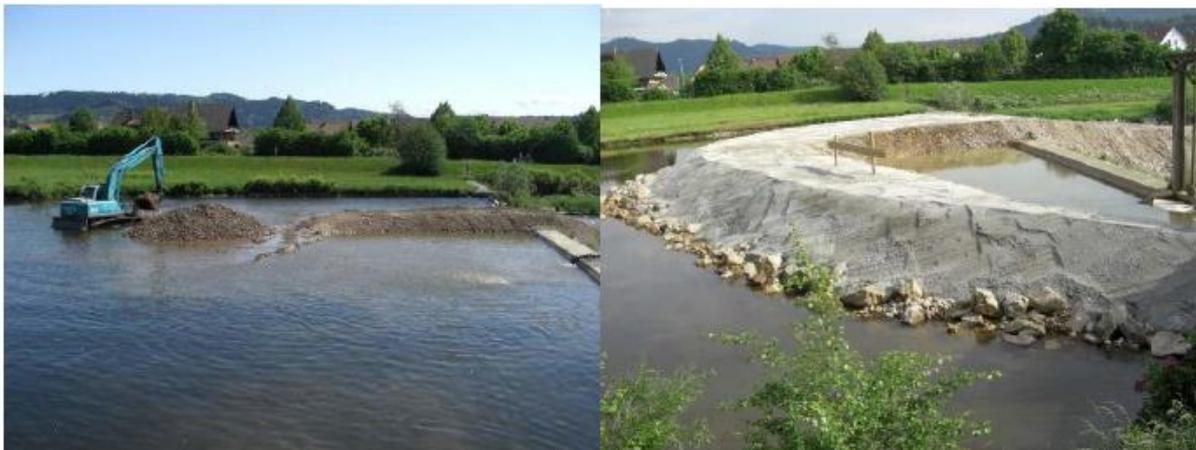
*Abb 5.1.3: Aufschütten und Befestigen eines Schutzwalls (Quelle:Abschlussbericht über die Projektstätigkeit vom 01.10.2006 bis zum 30.06.2011, S.20)*
