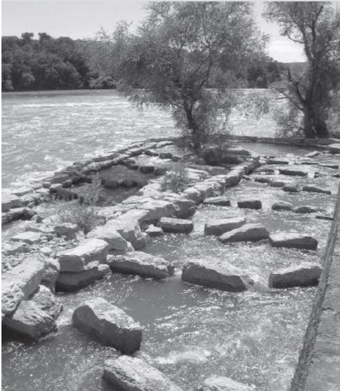
*Abb 2.2.2.1.1: Fischpass an Wasserkraftwerk Rheinfeld/Rhein (Quelle: Strobl 2006)*
