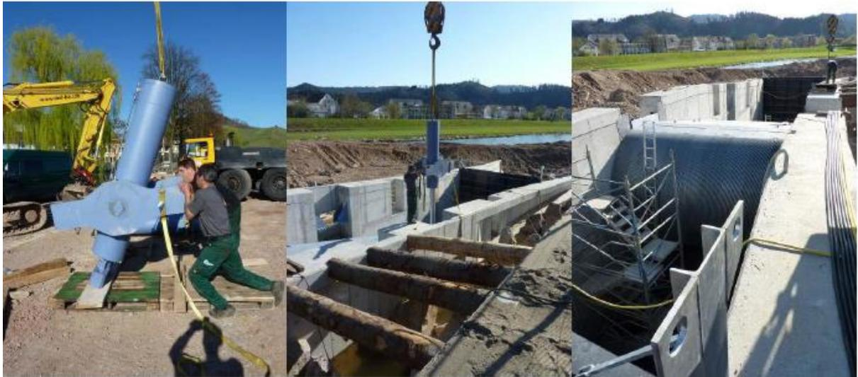
*Abb 5.1.8: Einbau der Hydraulikzylinder und Test der Passagenauigkeit des Fischrechens (Quelle: Abschlussbericht über die Projektstätigkeit vom 01.10.2006 bis zum 30.06.2011, S.22)*
