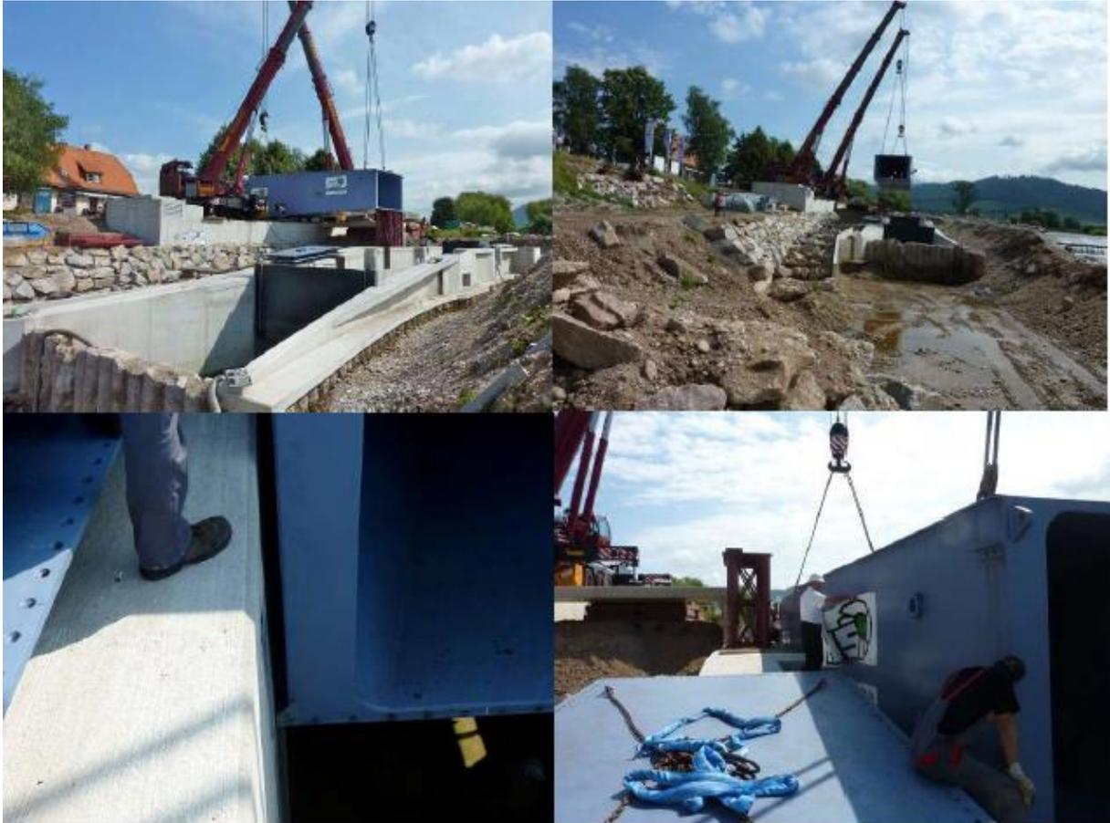
*Abb 5.1.14: Einheben des Krafthauses (Quelle: Abschlussbericht über die Projektstätigkeit vom 01.10.2006 bis zum 30.06.2011, S.26)*
