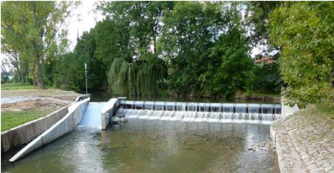
*Abb 5.1.1: WKA Bad Sulza, 2009:Inbetriebnahme der Versuchsanlage (Quelle:Anhang 21: Vorträge anlässlich des Symposiums im Offenburg,Entwicklungsschritte Bewegliches Krafthaus, S.8)*
