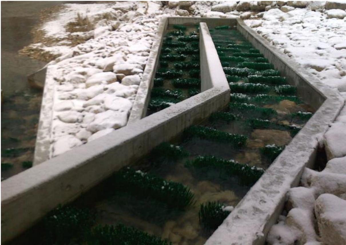
*Abb 5.2.2:Borstenfischpass (Quelle:[www.hydroenergie.de](http://www.hydroenergie.de))*
