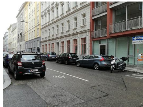
Abb. 82: Bodenmarkierung mit Fahrradpiktogramm und Warnlinie im Mündungsbereich der Kreuzung (Quelle: eigenes Foto, 16.02.2018)
