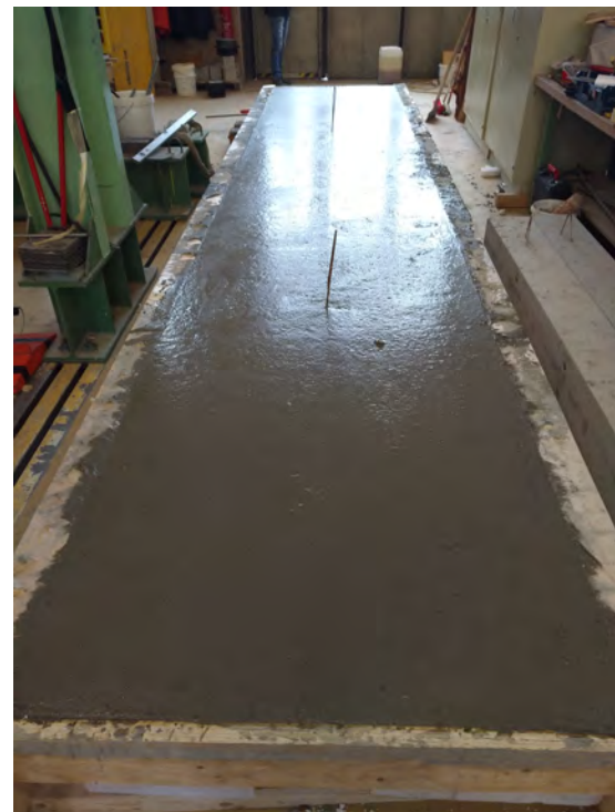
(b) Ausbetonierter Träger
