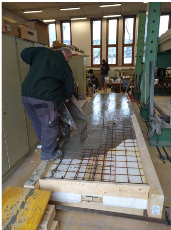
(a) Einbringen des Betons
