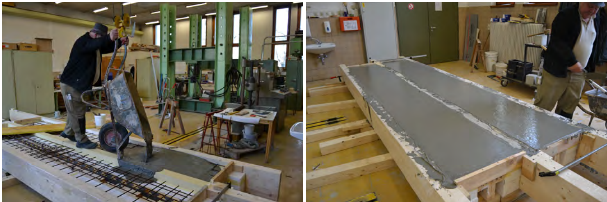
(a) Einbringen des Betons
