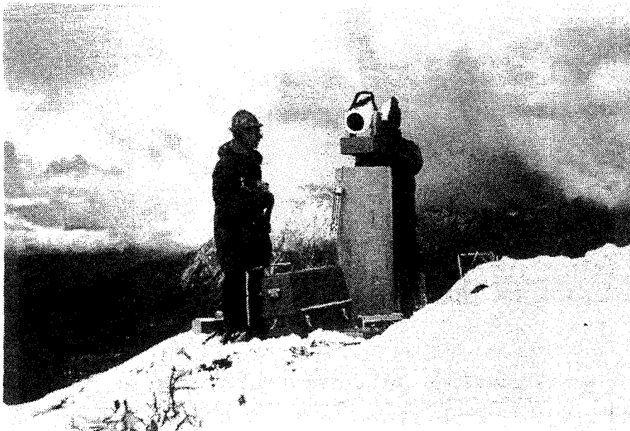
Bild 6: Deformationsmessungen für die Kraftwerksgruppe Sellrain-Silz
