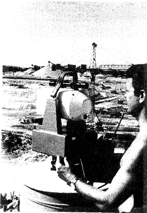
Bild 5: Tellurometermessung für Grundlagennetz beim Kraftwerk Abwinden-Asten
