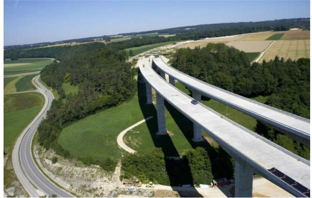
Abbildung 12: Autobahnviadukte vor Deckschichteinbau [25]
