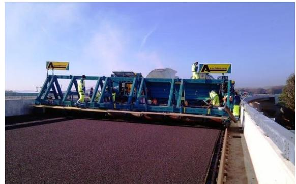
Abbildung 14: Einbau der Gussasphalt-Deckschicht mit einem schienengeführten Einbaufertiger mit integrierter Splittabstreuung [25]
