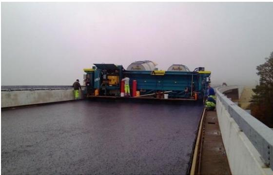
Abbildung 13: Maschineller Einbau der Gussasphalt-Schutzschicht mit einem schienengeführten Einbaufertiger. [25]
