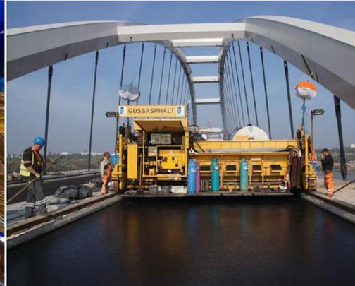
Abbildung 10: Asphaltfertiger während des Einbaus vom Gussasphaltbelag [23]
