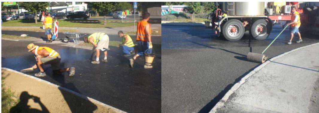
Abbildung 11: Händischer Einbau des Gussasphalts (links) und Oberflächenbehandlung (rechts) [24]
