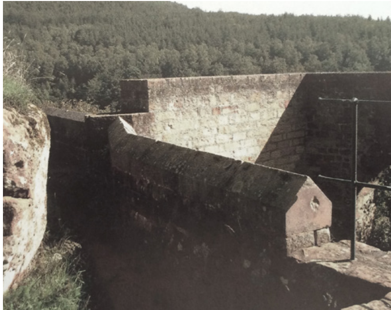
Abb 37 Steinsichtige Mauerkrone
