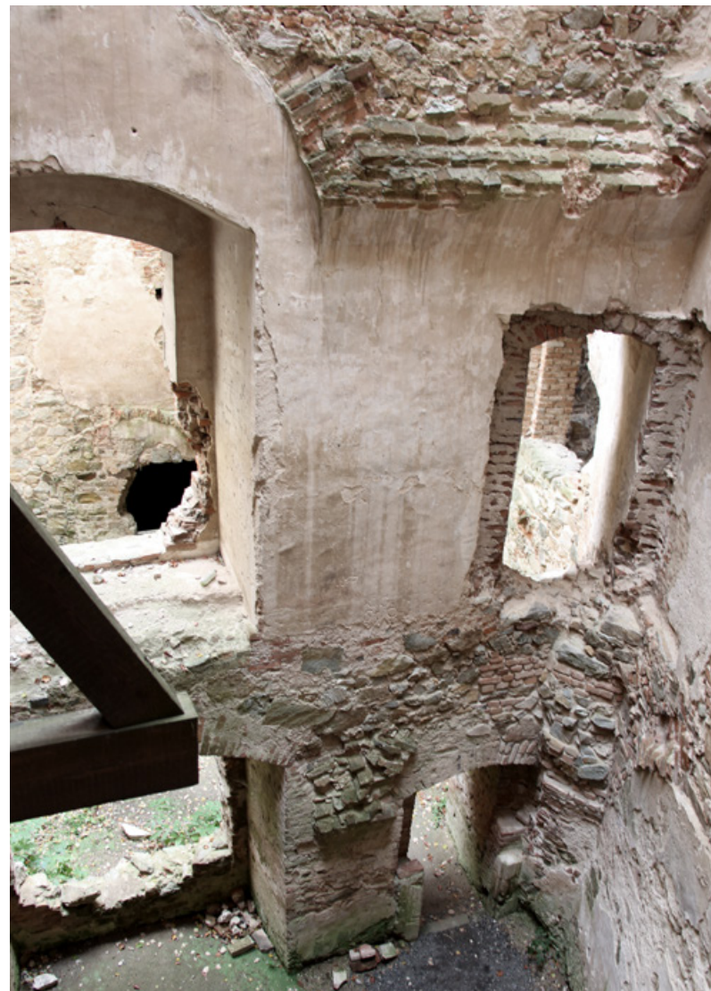
28 Stiegenhaus und Ausgang im Wohnturm (mit deutlichen Kennzeichen von Geschosshöhen, Fensterleibungen, Erweiterungen und Ausbesserungen)
