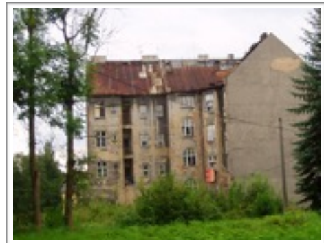
Abb.05: Eines der wenigen noch erhaltenen Gebäude in der Altstadt von 2013
