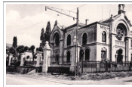
Abb. 68: Ansicht nach dem Straßenbahnbau
