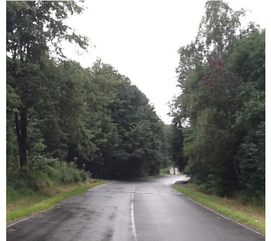
Abb. 131: Aktuelle Situation vor Ort
