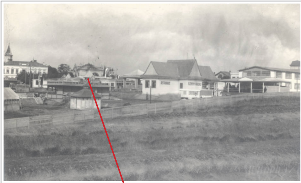
Abb. 102a: Foto mit seitlichem Blick auf die Südfassade
