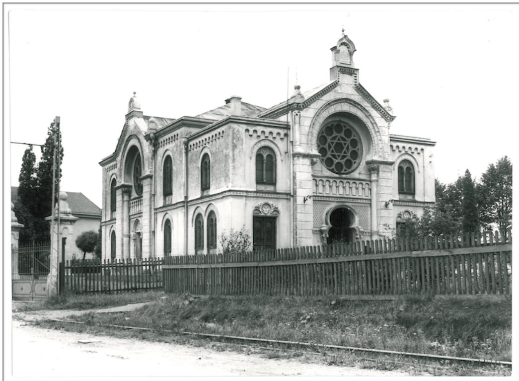
Abb. 96: Foto Westfassade - Eingang mit den Straßenbahngleisen im Vordergrund, ca. 1935
