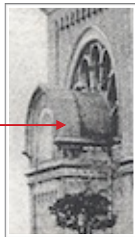
rechts: Bildausschnitt Ostfassade
