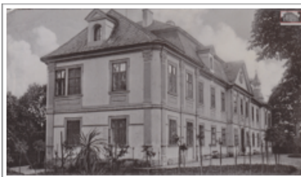
Abb. 47: Krankenhaus, ehemaliges Schloss Orłau
