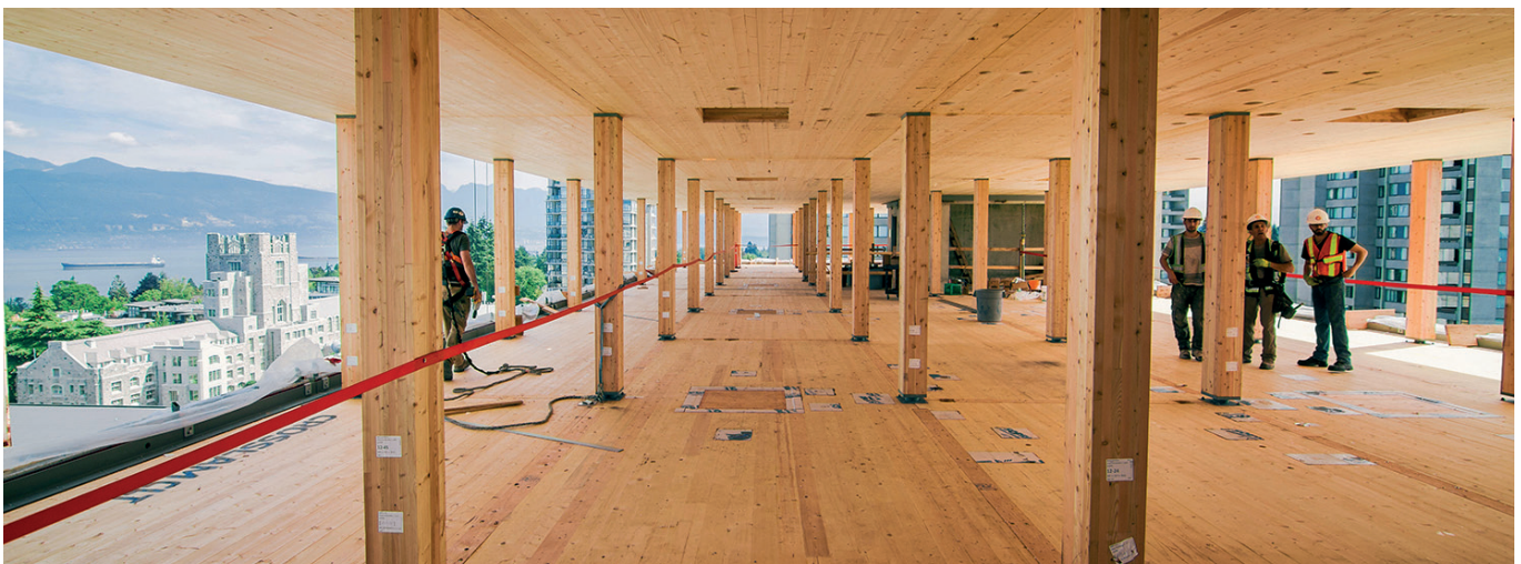
2.11 Ansicht 2.12 Baufortschritt 2.13 Baufortschritt
