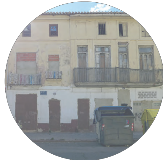
/// Leerstehendes Gebäude mit vermauerten Öffnungen
