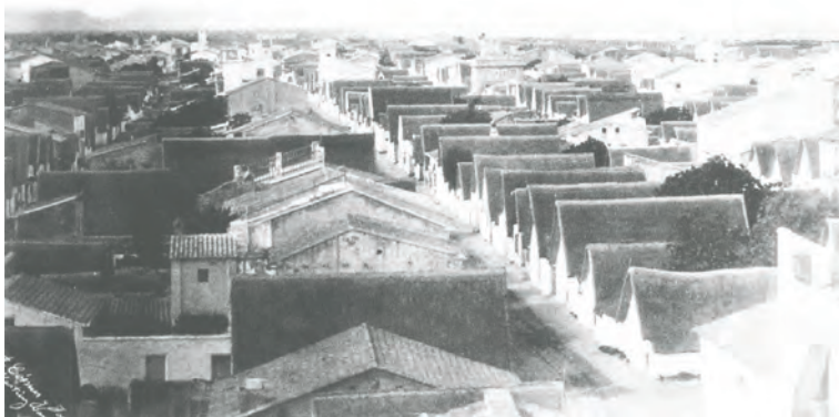
Abb.35 Historische Ansicht eines Straßenzuges in 1858
