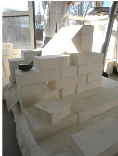
**Abbildung 3.15:** Bau des Versuchsbrandofens (Rutschenkonstruktion)
