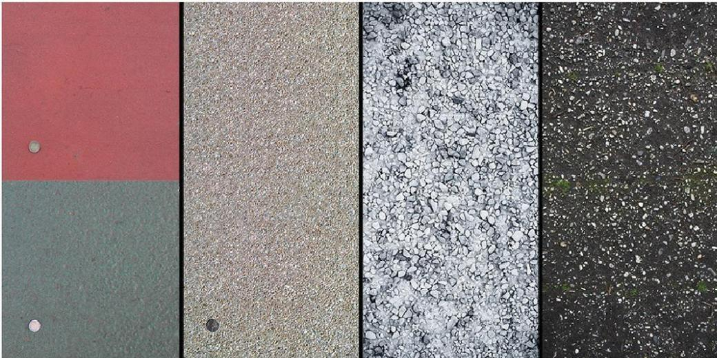
Von Links nach Rechts: Flächige Radwegmarkierung | "Terraway"- bzw. "Stabilizer"-Belag (gebundener Kies und Split; wasserdurchlässig und atmungsaktiv) | Schotter | Gewachsener Boden (=Erde)
