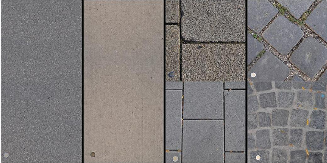
Von Links nach Rechts: Asphalt | Beton | Große Pflastersteine | Kleine Pflastersteine
