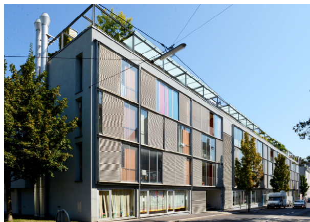
Abbildung 120 Haus Hagen Westseite. (Quelle: © Sabina Riß, 2016)
