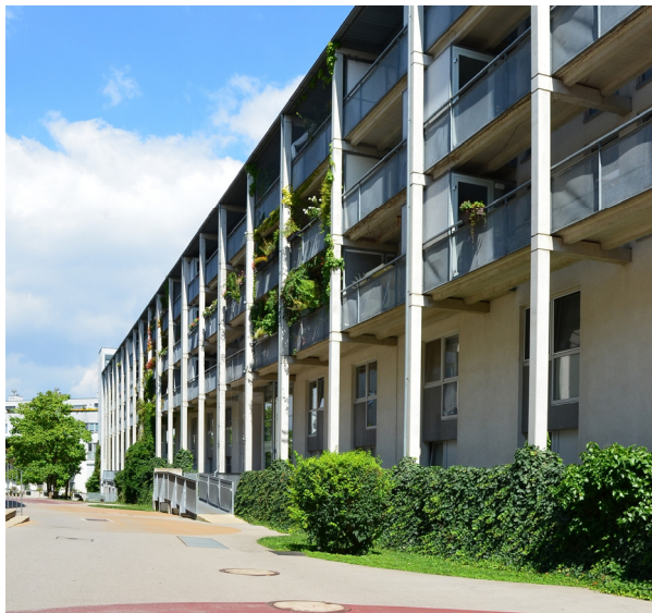
Abbildung 57 Bauteil Podreka. Westseitige Laubengänge und Loggien. (Quelle: © Renate Prewein, 2016)
