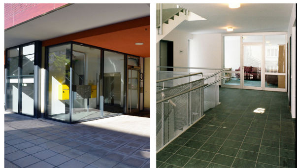
Abbildung 160 Zugang Stiegenhaus Bauteil B. (Quelle: © Renate Prewein, 2016)
