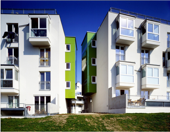
Abbildung 51 Bauteil Prochazka. Westseitige Erker zur Spielwiese. (Quelle: © Margerita Spiluttini Fotoarchiv Architekturzentrum Wien, 1998)
