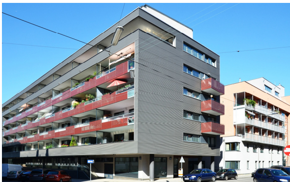
Abbildung 153 Bauteil C von Ganahl Ifsits Larch Ecke Graffgasse / Fernkorngasse. (Quelle: © Renate Prewein, 2016)
