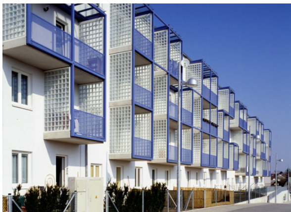
Abbildung 63 Bauteil Peretti. Ostseitige Balkone. (Quelle: © Margerita Spiluttini Fotoarchiv Architekturzentrum Wien, 1998)
