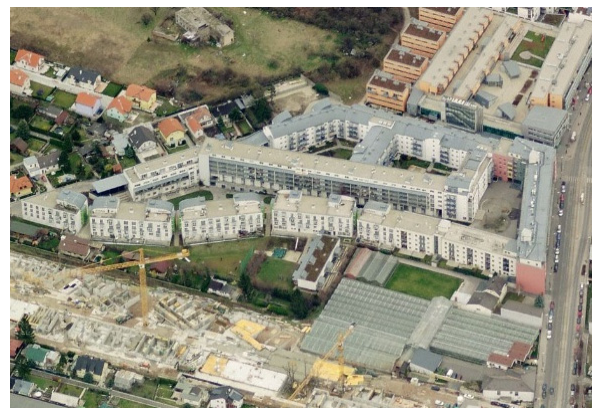
Abbildung 36 Luftbild (Quelle: https://www.bing.com/ Zugriff am 13.3.2016)
