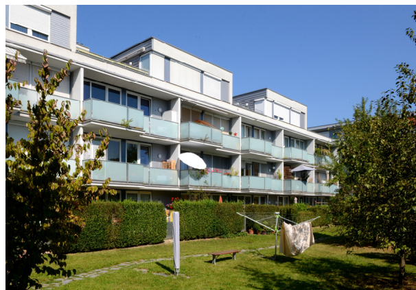
Abbildung 141 Haus Mitte, Südseite Hofgrünraum. (Quelle: © Sabina Riß, 2016)
