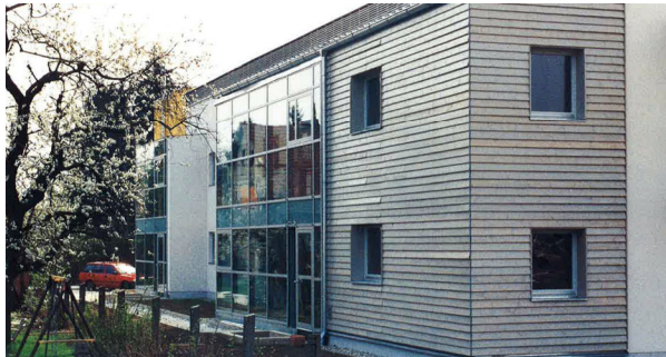
Abbildung 77 Nordwestseite des Gebäudes mit Erschließung. (Quelle: © Foto Lohr – Stadt Graz, 1997)
