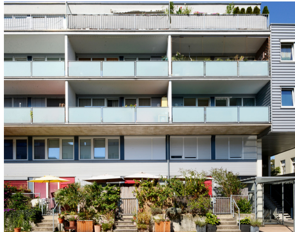
Abbildung 138 Haus Bahn, Südfassade mit Loggien und Vorgärten. (Quelle: © Sabina Riß, 2016)
