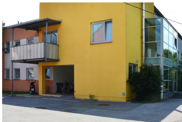
Abbildung 75 Parkplätze, Fahrradabstellbereich und Zugang an Nordostseite. (Quelle: © Renate Prewein, 2016)
