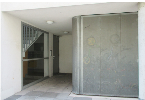
Abbildung 54 Bauteil Prochazka. Von außen zugänglicher Fahrradabstellraum je Stiege (Quelle: © Sabina Riß, 2016)
