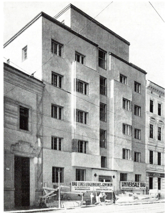
Abbildung 10 Ledigenheim, Architektin Ella Briggs-Baumfeld, Wien 1926. (Quelle: Bauwelt 1928, H.48, S. 1132)
