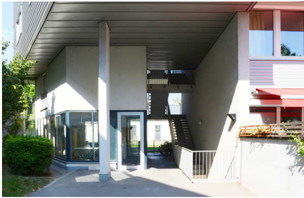
Abbildung 133 Waschküche bei Stiegenhaus Haus Bahn. (Quelle: © Sabina Riß, 2016)
