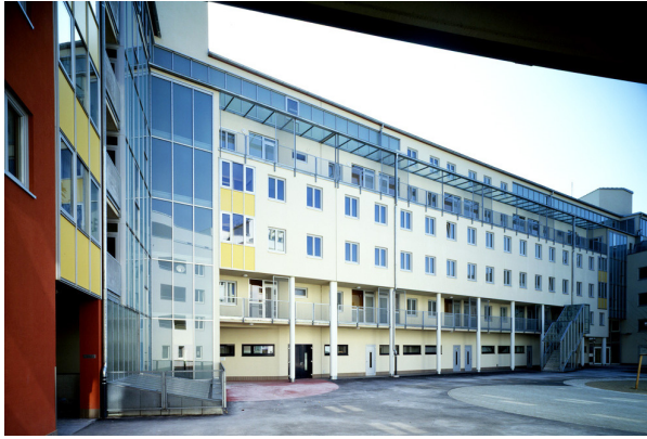
Abbildung 46 Bauteil Ullmann Donaufelder Straße. Platz. (Quelle: © Margerita Spiluttini Fotoarchiv Architekturzentrum Wien, 1998)
