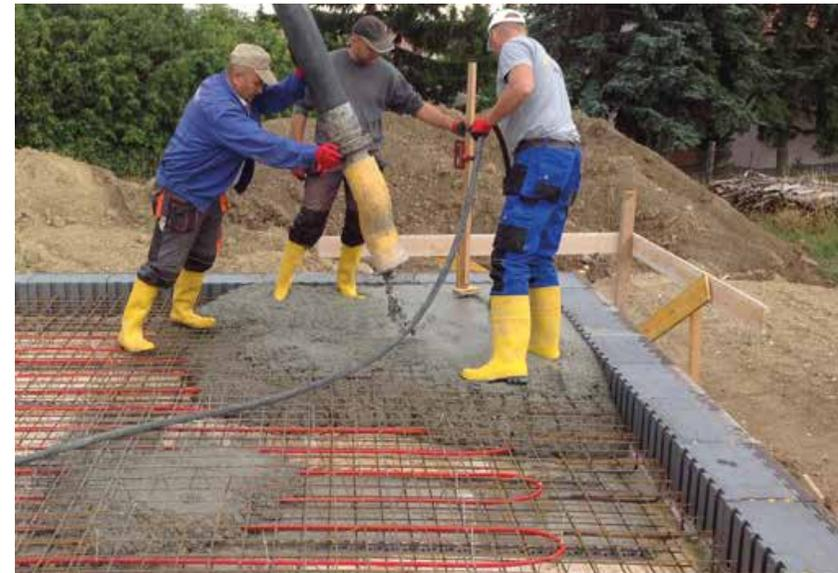
Abbildung 77: Thermische Aktivierung der Betondecken
