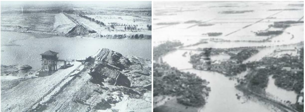
Abbildung 2.5: Banqiao Damm nach der Katastrophe (links), Quelle: Fish (2013); überflutete Unterlieger des Dammes (rechts), Quelle: Henan Provincial Water Resources Bureau, <http://www.newschinamag.com/magazine/dams-in-distress> [Zugriff: 11.1.2016]
