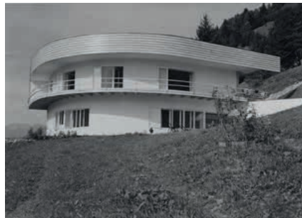
Abb. 46: Haus Heyrovsky (1932); Architekt Lois Welzenbacher.
