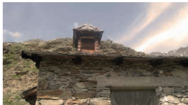
Abb. 113: Detail Material: Mauer und Schindeldach
