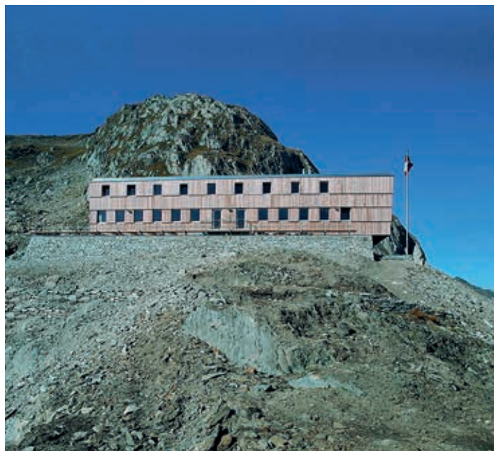
Abb. 31: Cristallina-Hütte Ansicht Süden
