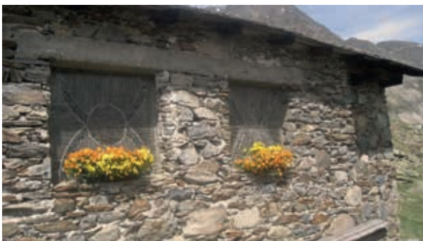
Abb. 112: Südansicht mit Fenster
