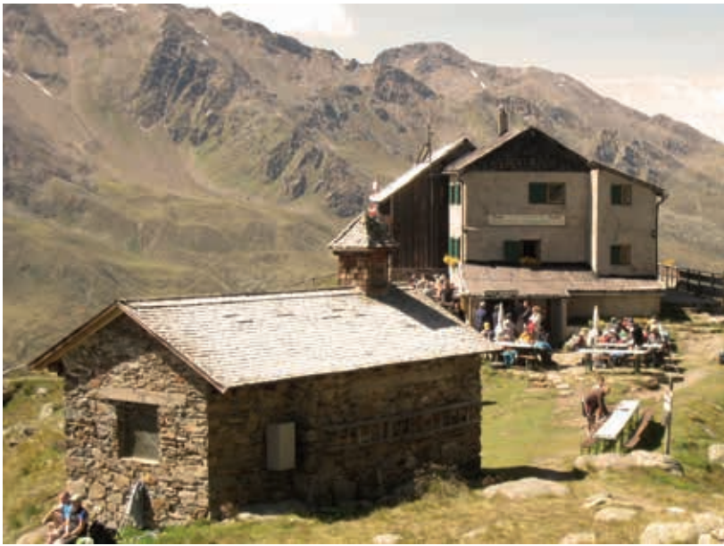
Abb. 110: Gebäudeensemble Kapelle mit Schutzhütte
