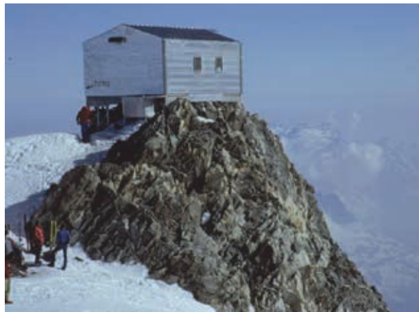
Abb. 11: Neue Refuge/Biwak Vallot, Architekt Paul Chevallier, erbaut 1934 -1938 auf 4.387m Erste Experimente mit neuen Materialien wie Metallplatten als Fassadenverkleidung.
