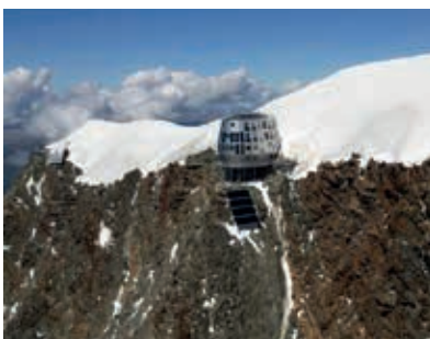
Abb. 29: Refuge de Goûter auf 3.835m im Mont Blanc- Massiv (Frankreich)
