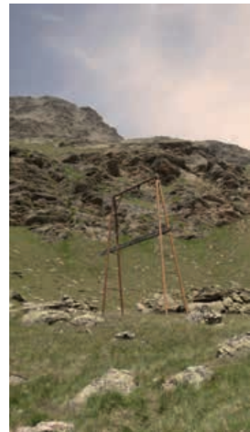
Abb. 124: Materialseilbahn-Stützen aus Stahl
