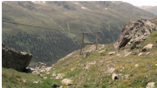
Abb. 121: Materialseilbahn-Stützen aus Holz
