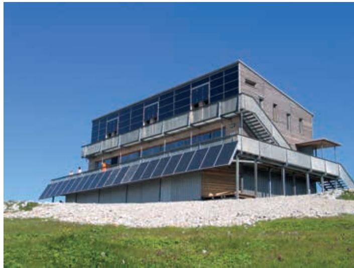
Abb. 33: Schiestlhaus Ansicht Südost
