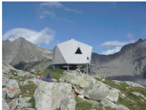
Abb. 24: Stockhornbiwak, errichtet 1974 auf 2.598m
