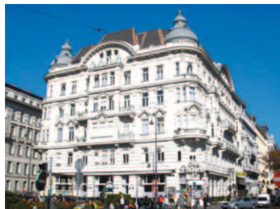
Abb. 38: Wohn-, Büro und Geschäftshaus, Wien 1, Stubenring 24 / Dr. Karl Lueger Platz 6 / Biberstraße 2
