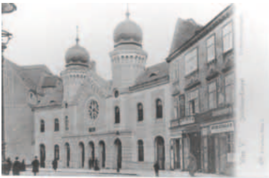
Abb. 41: Synagoge, Wien 5, Siebenbrunnengasse 1 (1938 zerstört)
