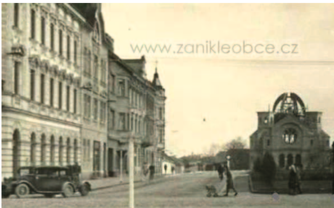
Abb. 74: Synagoge in der Bauphase im Jahr 1910
