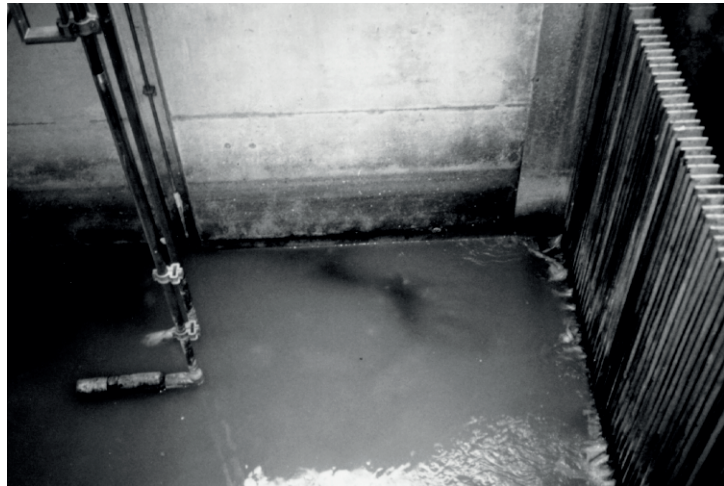
Bild 12: Installation der UV-Prozeß-Sonde und der Trübungssonde im Kanalsystem
