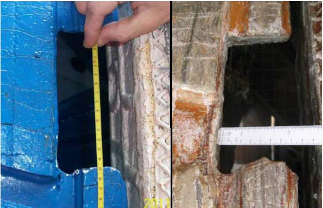
Abbildung 4.10: Materialeintrittsöffnung an der Schneiradseite [24]
