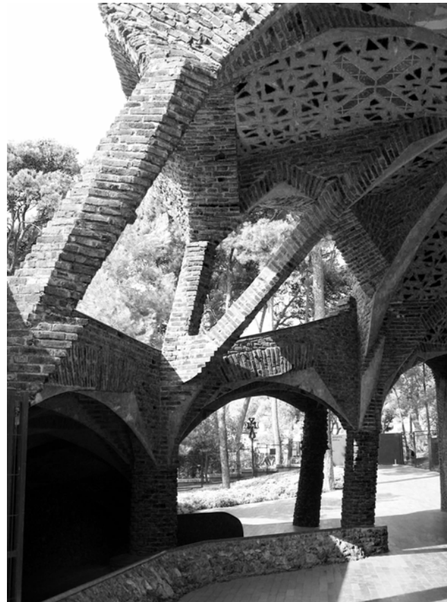
Abb. E11 Gemauertes Gewölbe der Krypta
