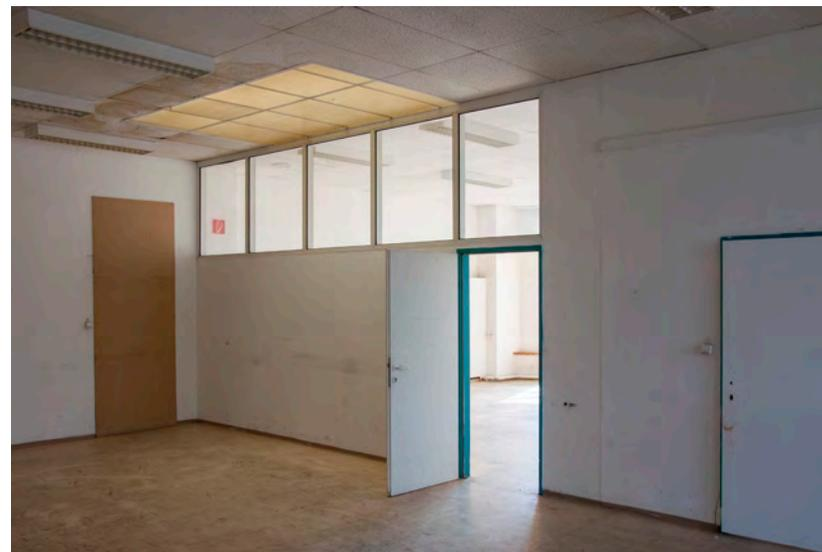
Abb. 142 Büroausbau mit abgehängter Decke
