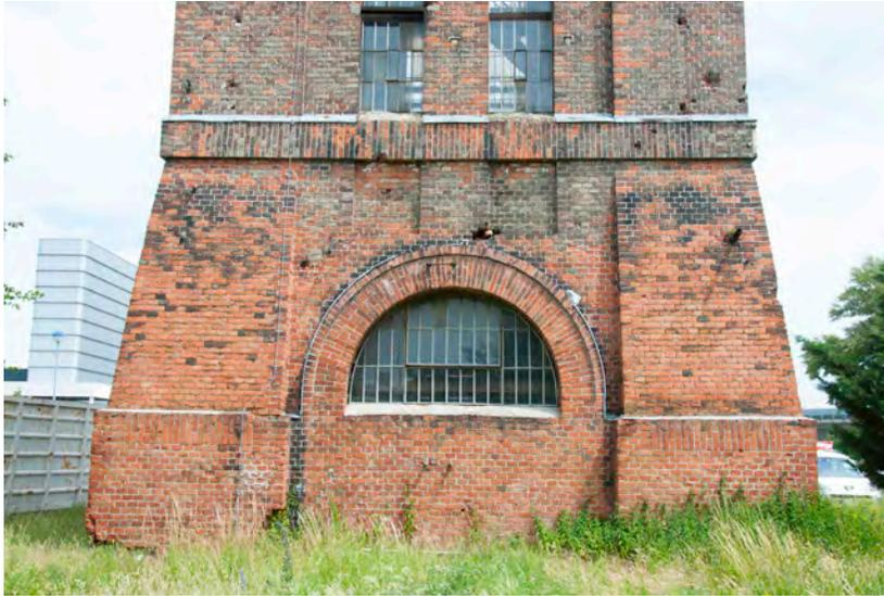
Abb. 165 Schadensbild ausgeschlagene Ziegel und fehlende Bleche
