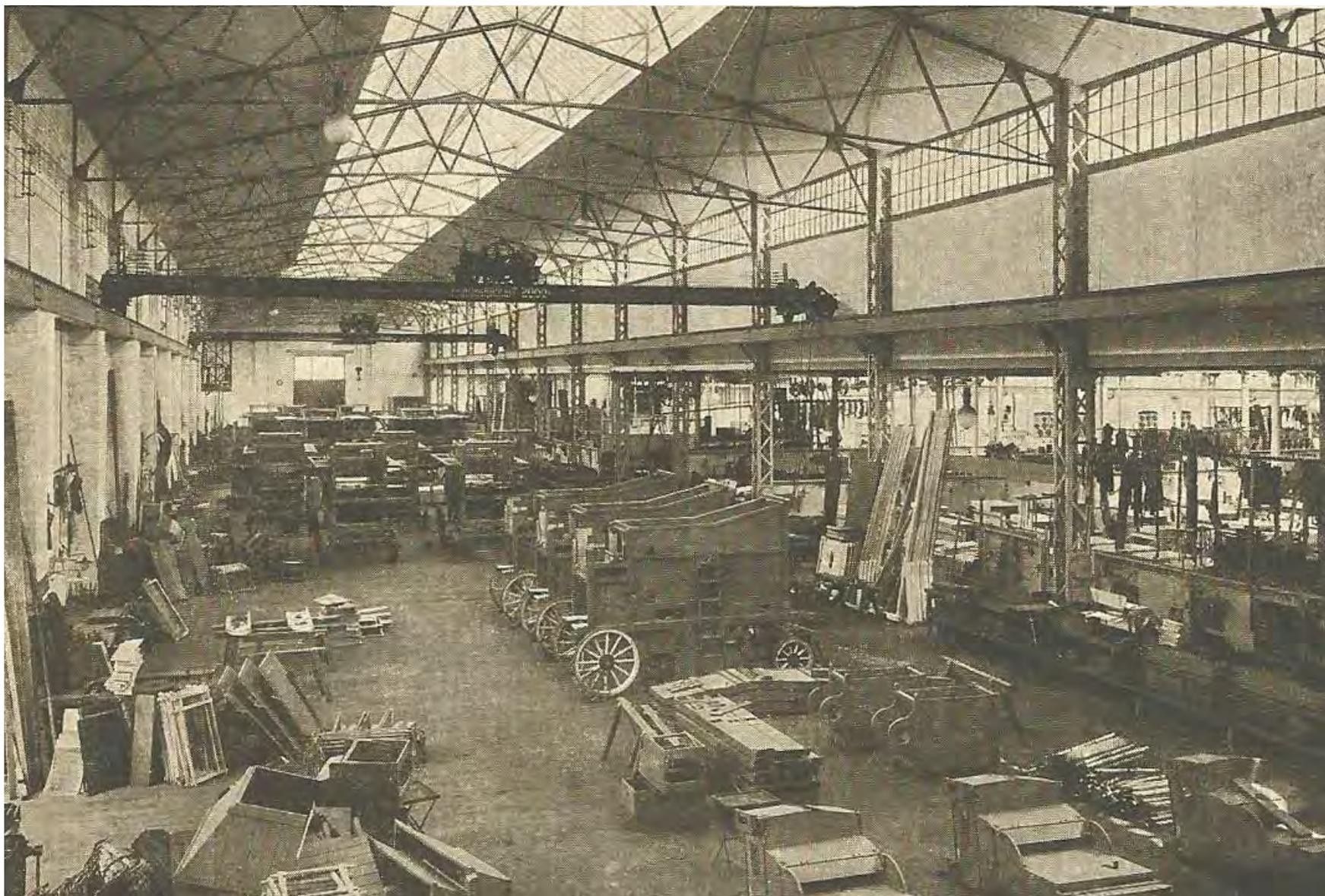
Abb. 51 Montierungshalle für Dreschmaschinen und elektrischen Laufkränen (XII)
