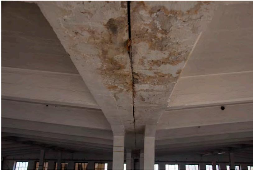
Abb. 155 Schadensbild durch unzureichende Dachentwässerung
