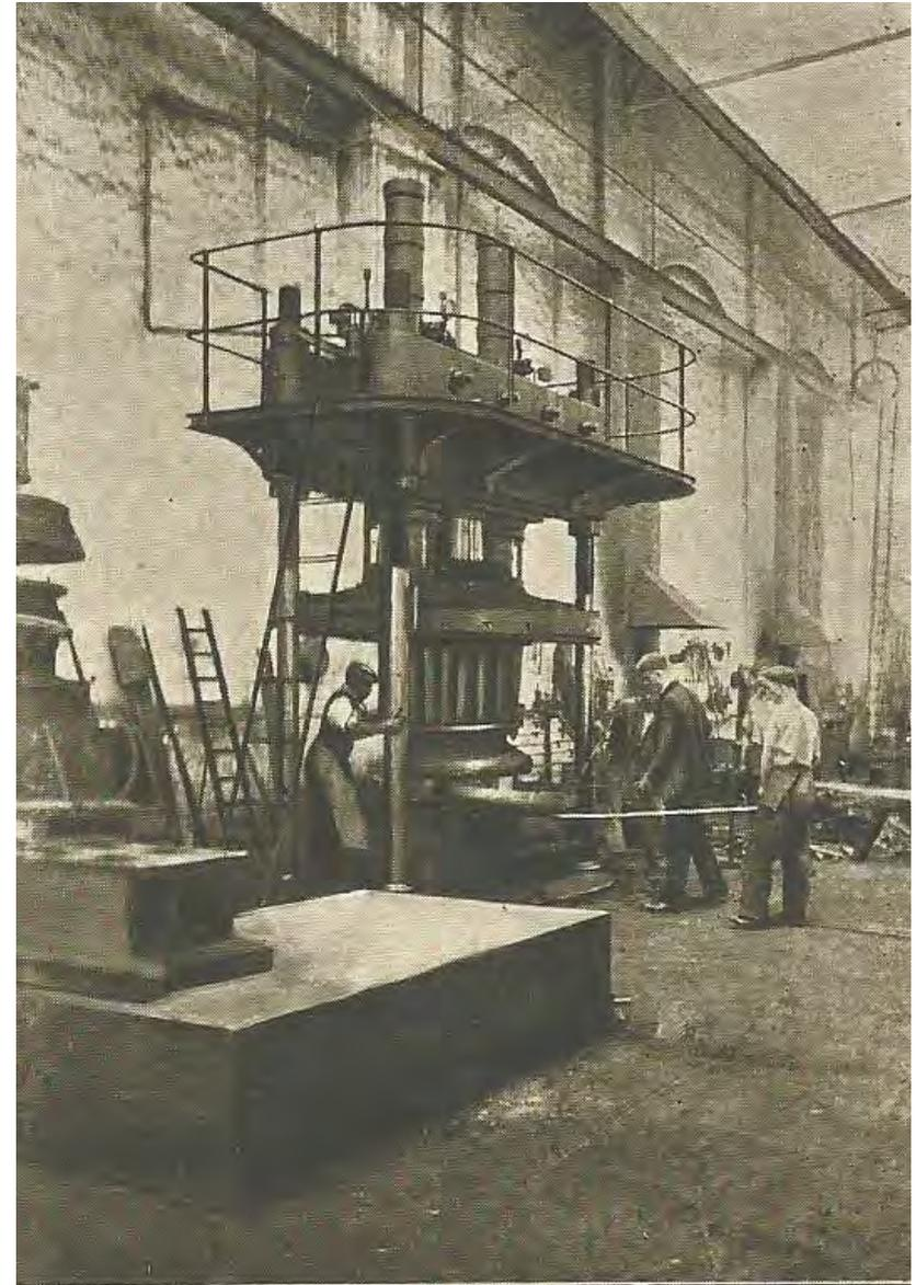
Abb. 48 Entnehmen des geformten Blechs
