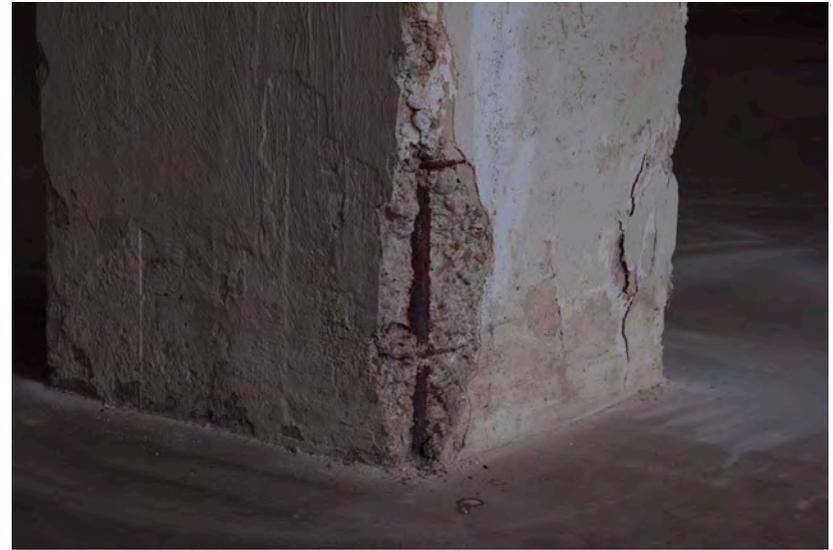
Abb. 156 Schadensbild korrodierter Bauteil
