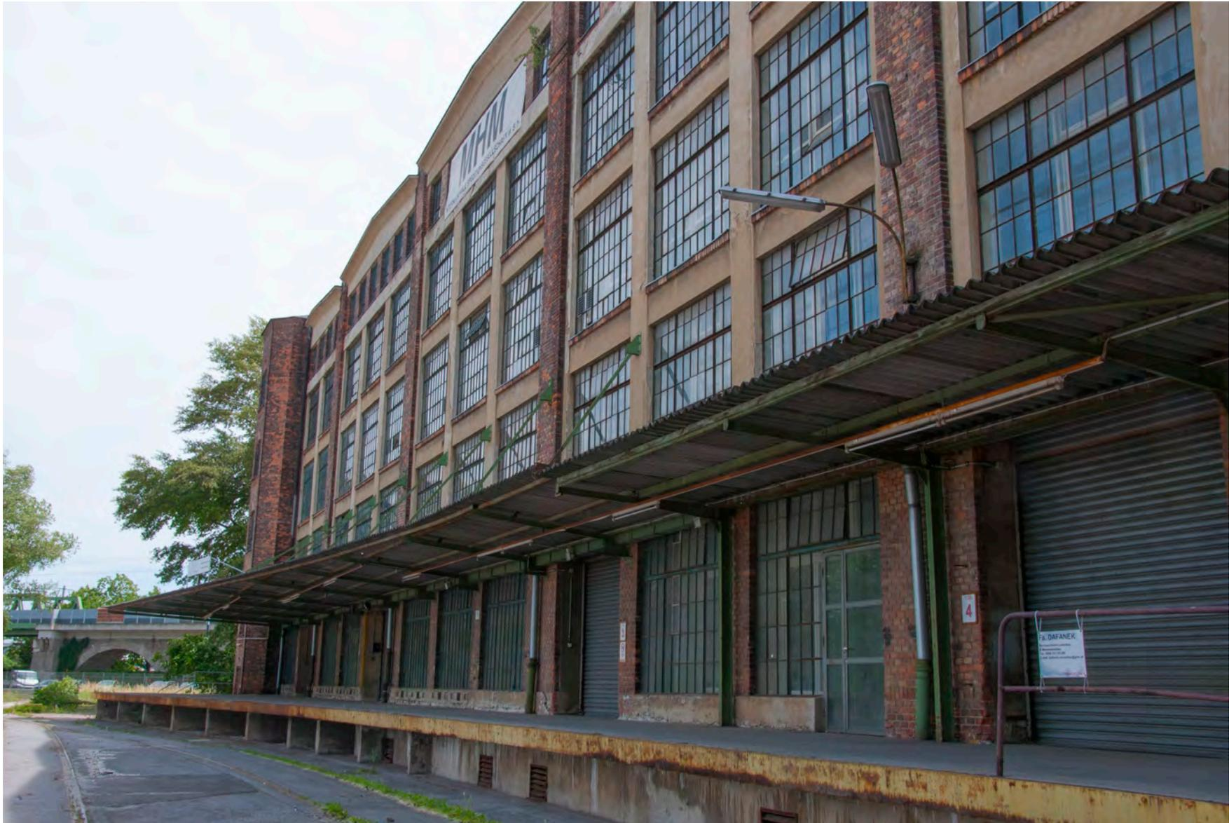
Abb. 124 Verladerampe und abgehängtes Dan an der Nordfassade
