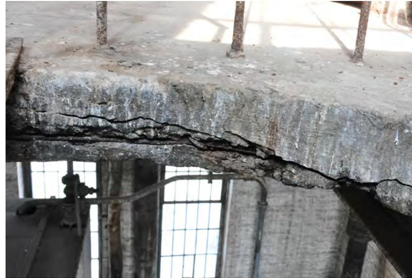
Abb. 170 Schadensbild Korrosion und abplatzen des Betons
