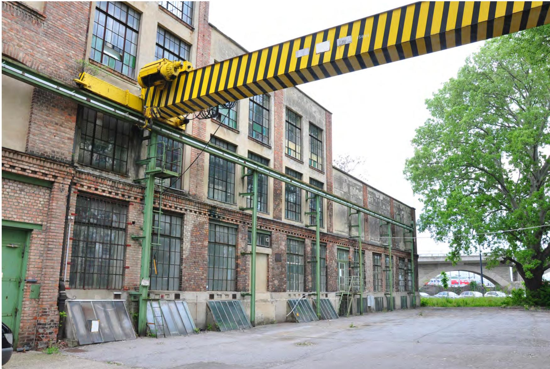
Abb. 132 Blick auf die Stützmauern vor der Terrassierung und Laufkran an der Westfassade
