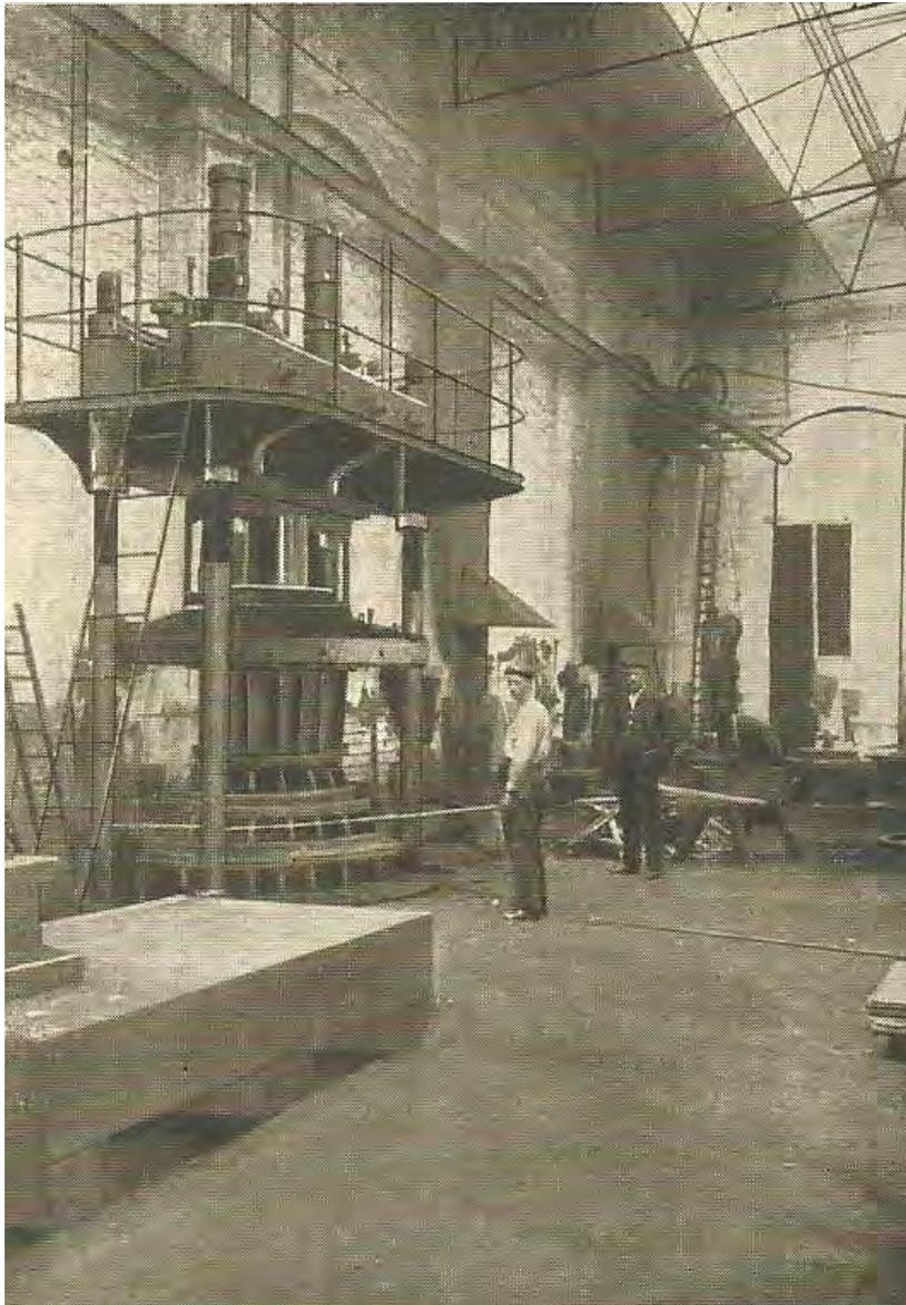
Abb. 47 Hydraulische Presse in Arbeit
