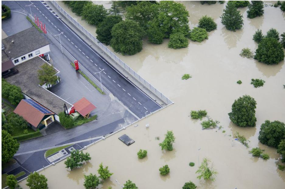
**Abb. 3 Mobile Hochwasserschutzwände kurz vor Überlastfall in Grein** (Quelle: Kermer 2013, <http://www.bundesheer.at/cms/artikel.php?ID=6599>)
