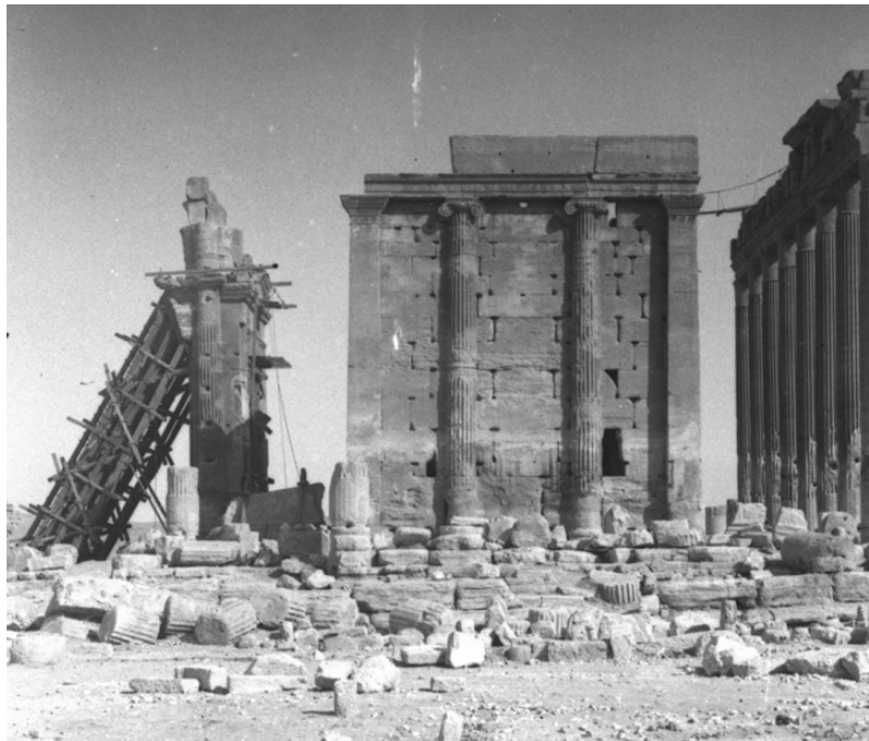
Abb. 54: Sicherung des einsturzgefährdeten Portals des Baal-Tempels 1930.
