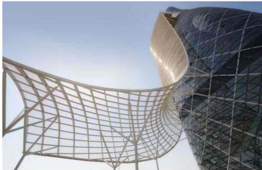
Abb.55 Eingangs Photovoltaich dach
