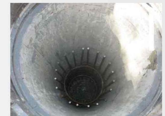
Abb.105 Einbau des Bewehrungskorbes und Betonieren des Schaftes
