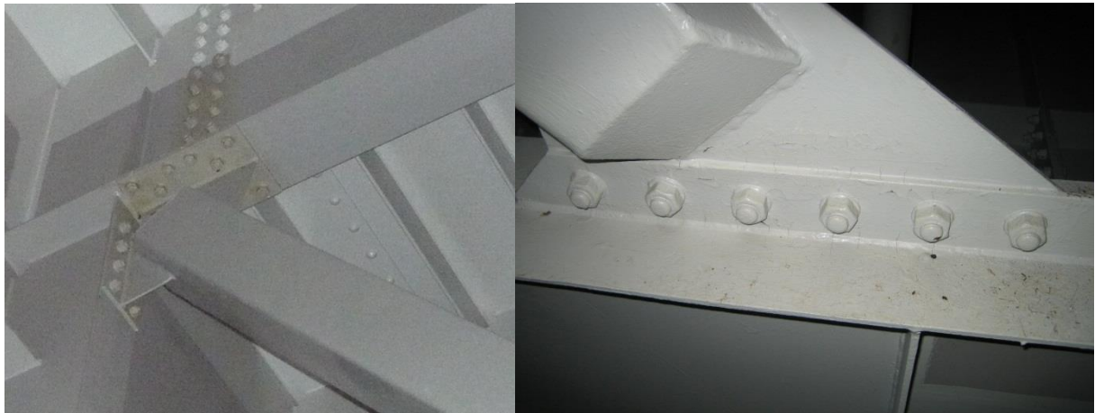
Bild 102: Unterer und oberer Montageanschluss der Diagonalstreben, Europabrücke
