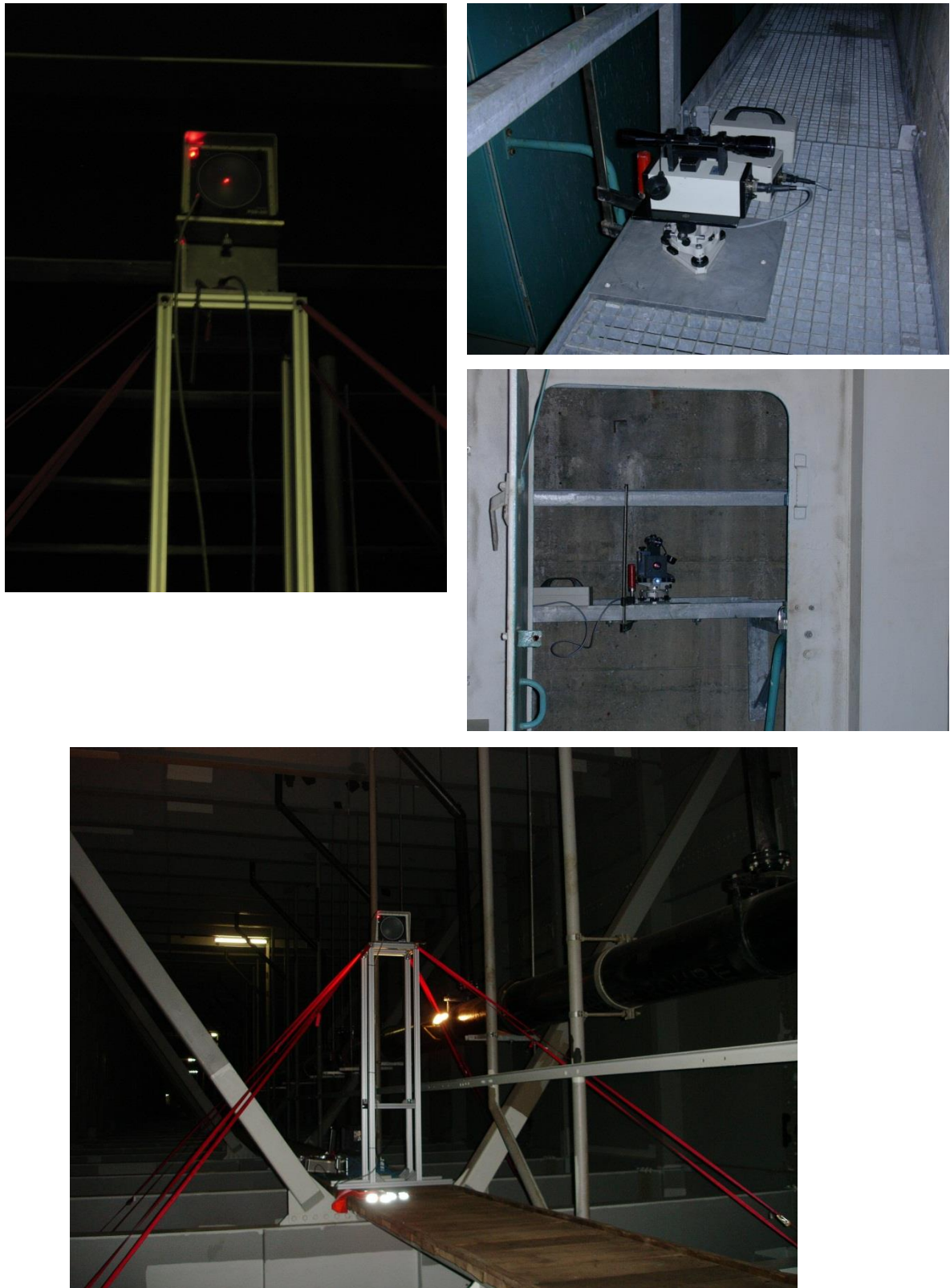
Bild 132: Kraftschlüssig mit der Bodenplatte verbundener Empfängerschirm (Brückenhauptfeld Nr. II) bzw. der im Bereich des Brückenwiderlagers Süd instrumentierte Laser-Sender (Feld II)
