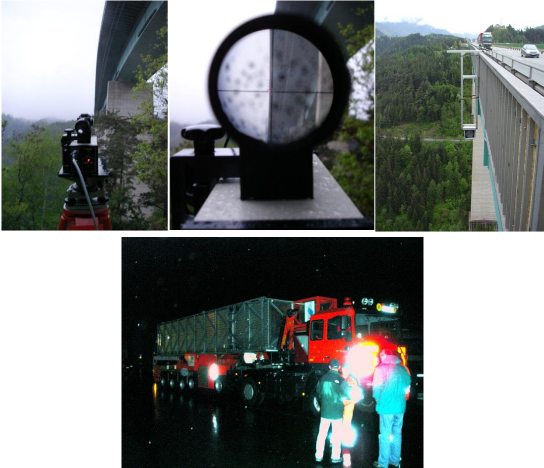
Bild 19: Instrumentierung des Messquerschnittes II (Laser-Sender beim Widerlager Patsch; Empfängerschirm kraftschlüssig am Gelände befestigt (oben) sowie das Brückeninspektionsgerät mit 5 Achsen und 42,8t Gesamttonnage (unten)
