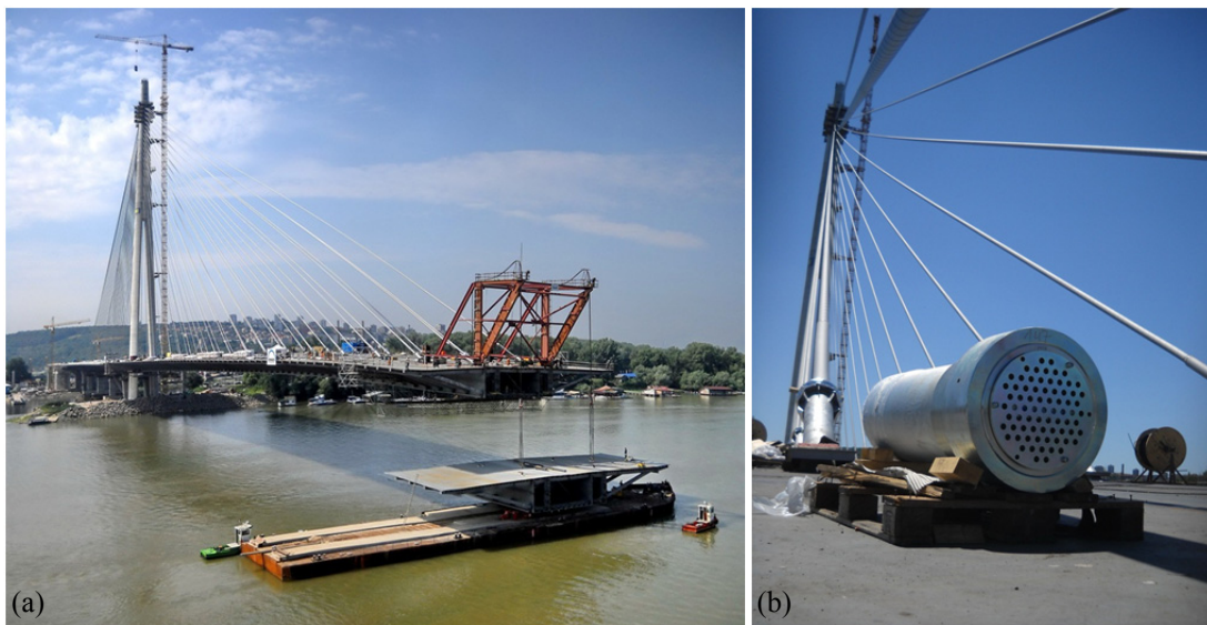
Abb. 1.1: Sava Bridge Serbien - Bauzustand (a) Verankerung vor Installation (b) [Sav11]
