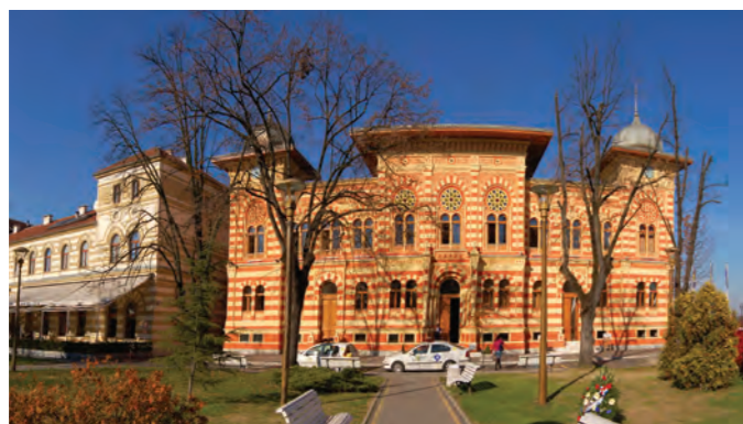
Abb. 32: Die Südfassade von Rathaus
