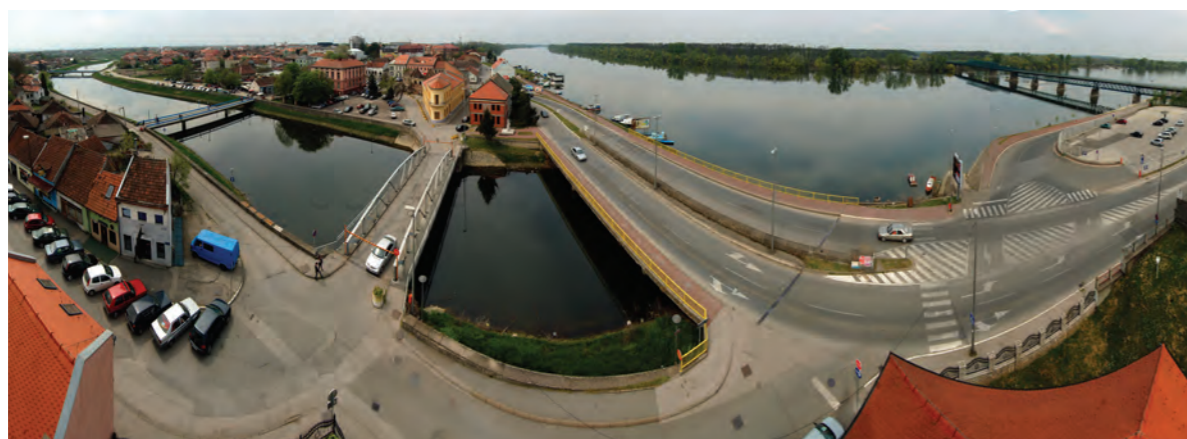
Abb. 45: Die verbindungs Brücken
