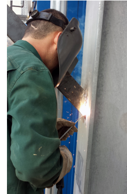
Abbildung 3.2: Anschweißen einer Rohrkonsole
