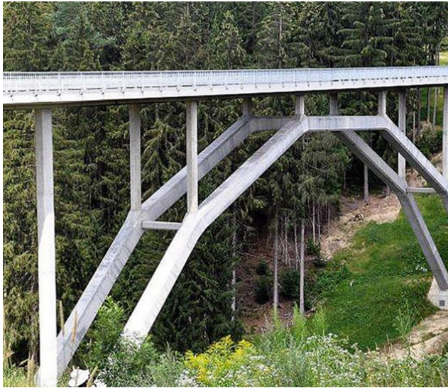
Abbildung 2-6: Die längste Brücke der Welt aus UHPC, Österreich, Kärnten [32]
