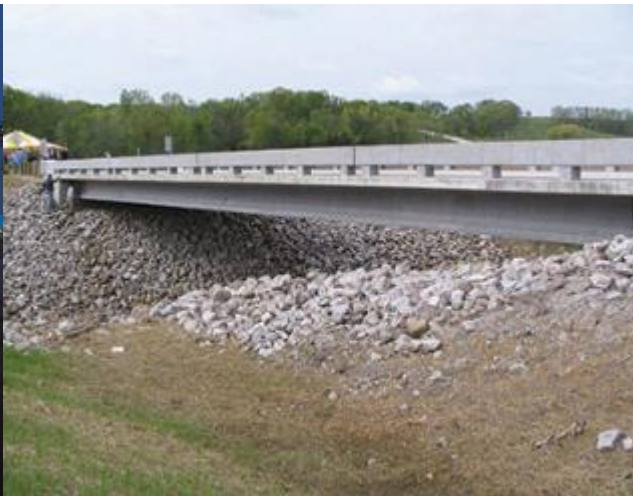
Abbildung 2-4: Die Brücke aus UHPC in Wapello [33]
