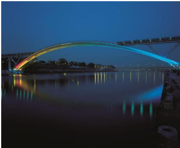
Abbildung 2-5: Sunyudo Brücke, Seoul, Korea Die Brücke aus UHPC [33]
