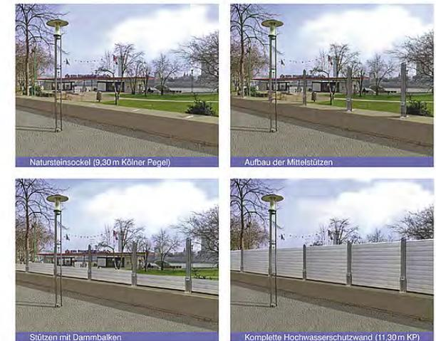
Abb. 4.22. Aufbau mobile Hochwasserschutzwand IBS
