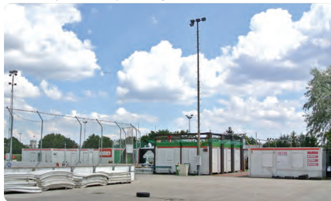
Abb. 030, Container am ASKÖ-Gelände
