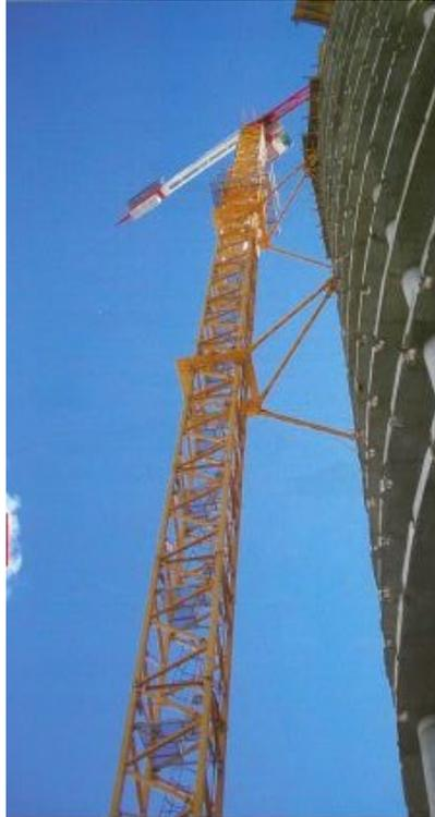
**Abbildung 5.52: Kletterkran mit Verankerung im Einsatz<sup>283</sup>**
