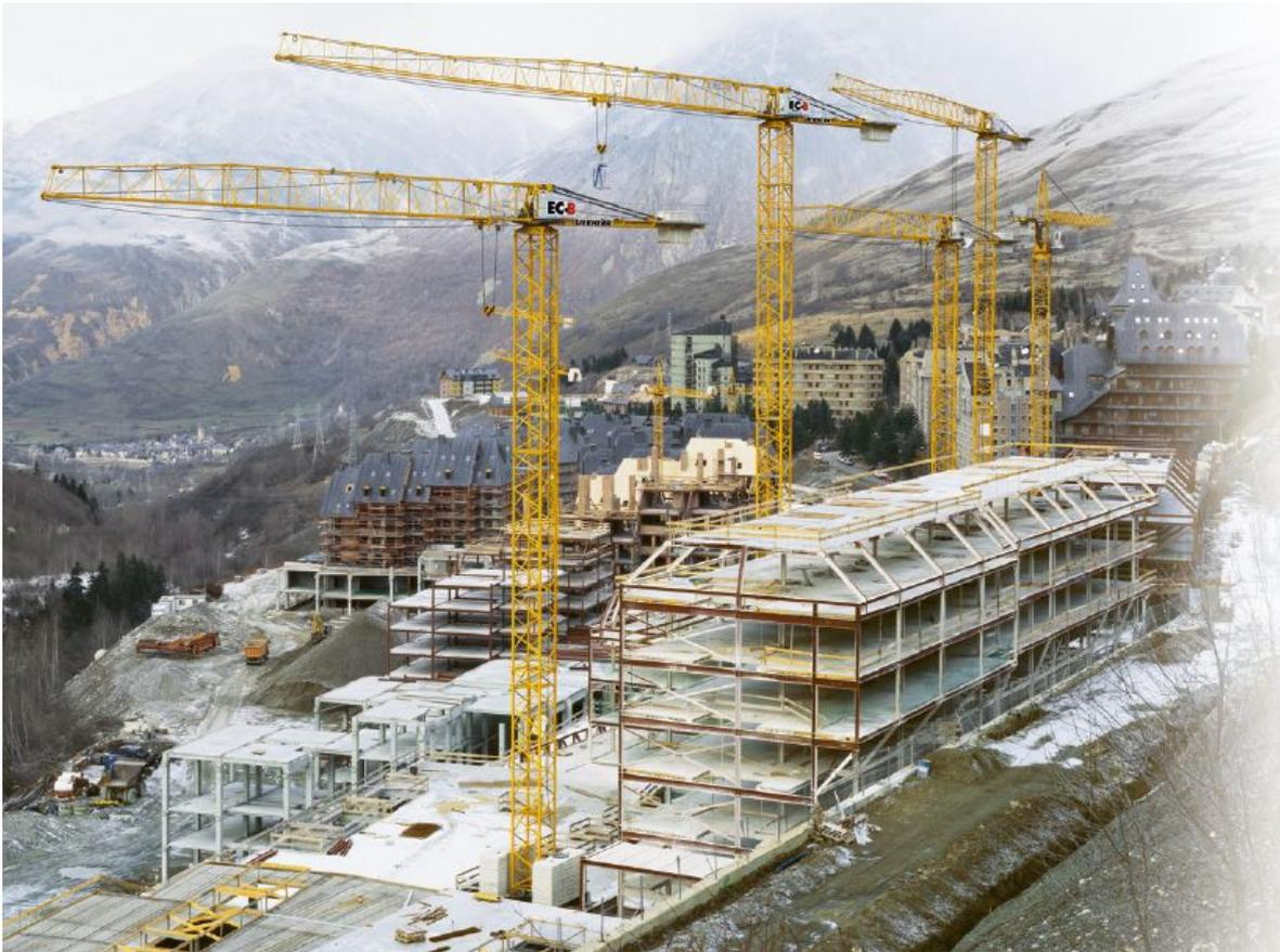
**Abbildung 5.14: Biegebalkenauslegerkräne im Einsatz<sup>193</sup>**
