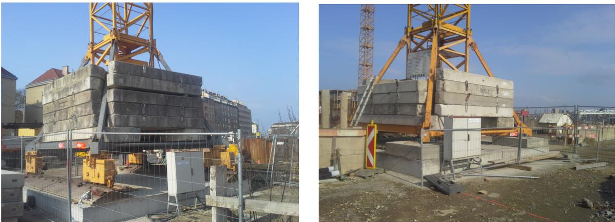
**Abbildung 5.27: Unterwagen auf Fundamentplatten oder Schienen<sup>228</sup>**
