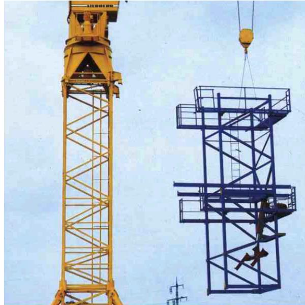
Abbildung 5.48: Kurzzeit-Klettereinrichtung der Firma Liebherr<sup>273</sup>
