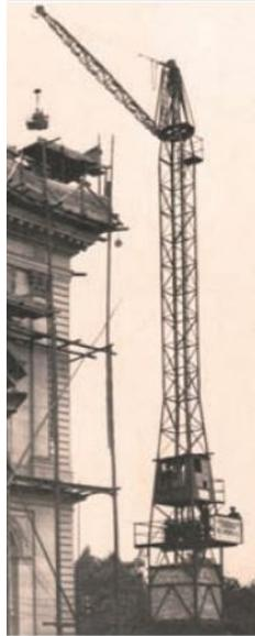
**Abbildung 2.14: Der erste Turmdrehkran von der Firma Wolffkran<sup>20</sup>**
