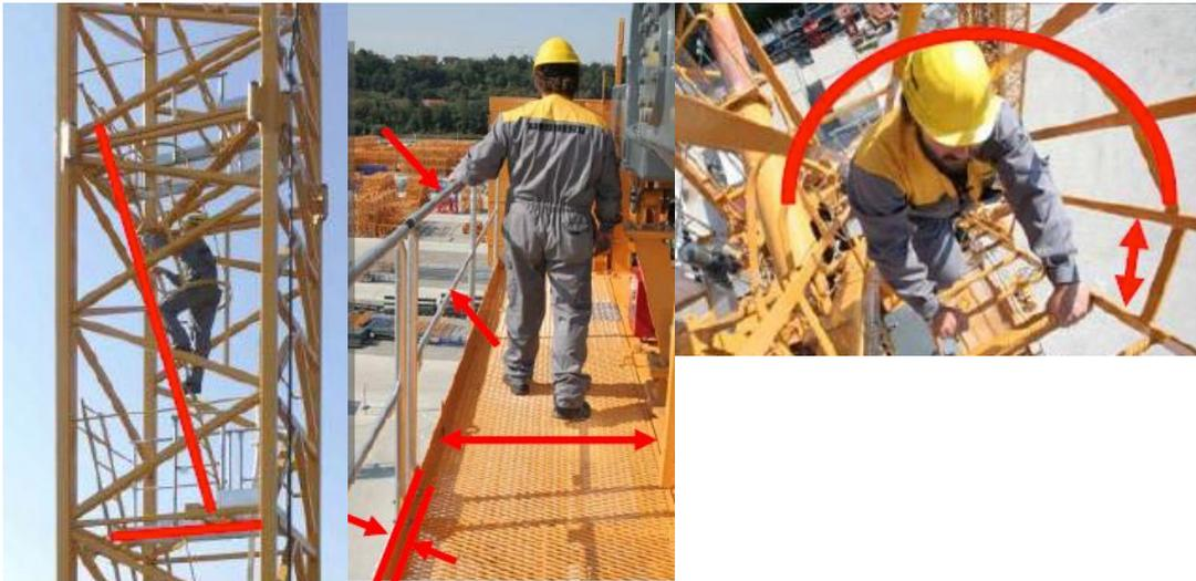
Abbildung 5.63: Sicherheitsausrüstungen<sup>312</sup>
