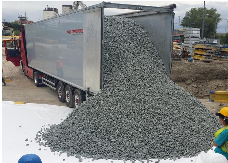
Abbildung 4.4: Anlieferung GSG lose per LKW (ca. 90 m<sup>3</sup>)
