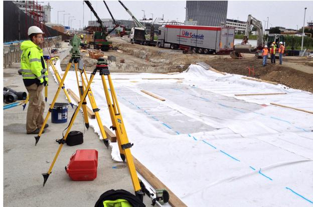
Abbildung 4.5: Vlies als Trennschicht zwischen Planum und GSG
