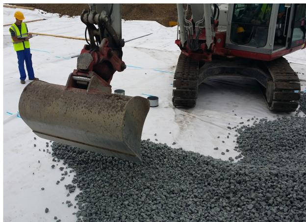
Abbildung 4.13: Materialeinbringung mit Raupenbagger von außen des Versuchsfeldes
