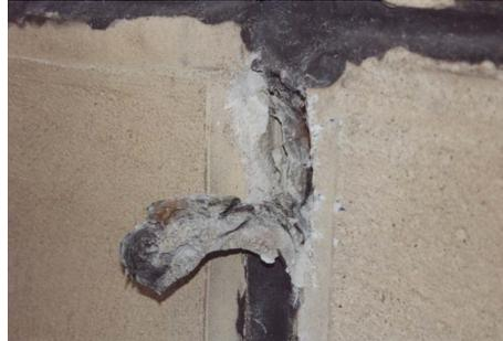
**Abb. 5.5:** Fugendichtstoff Morinol nach LEYDOLPH [33]
