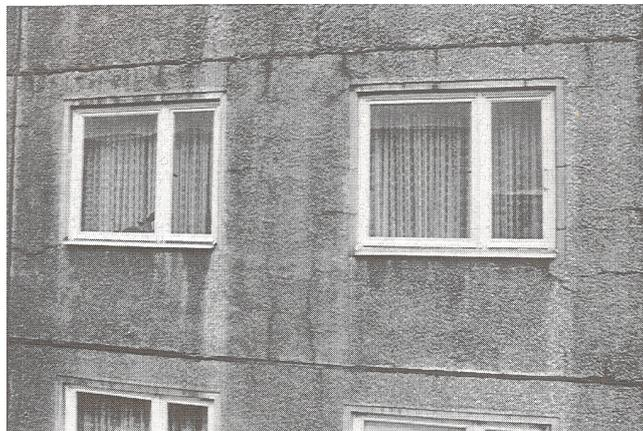
**Abb. 5.2:** Rissbild in einem Außenwandelement, aus BAUER et al. [14]
