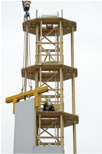
(a) Anbringen der BSH-Platten an das Leegerüst
