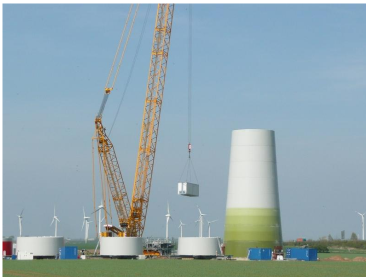
(a) Aufbau der Stahlbetonsegmente eines Betonvollfertigteilurmes [30]
