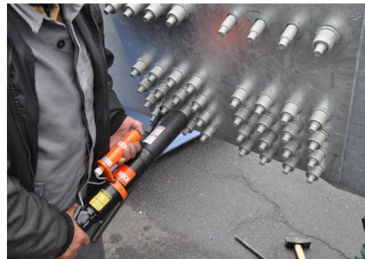
(b) Anbringen der Schließbolzen
