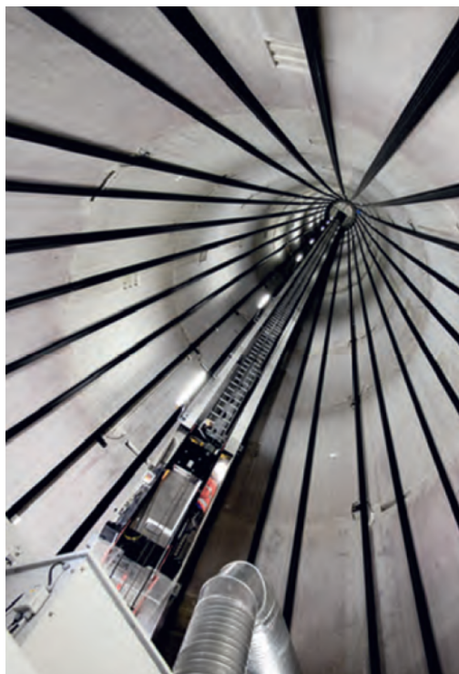
(c) Externe Vorspannung im Inneren des Stahlbetonturmes
