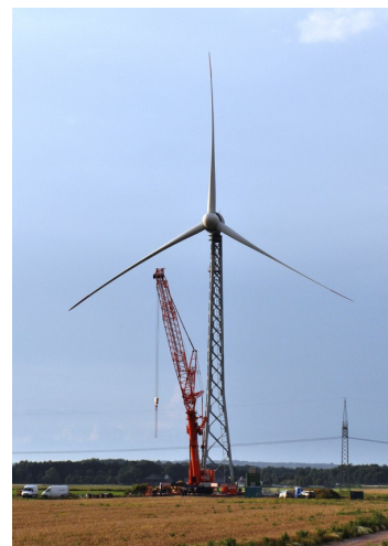
(d) Prototyp des Gitterturmes in Neuenbrook
