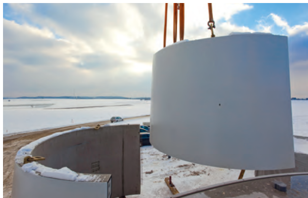
(a) Manövrieren der Segmentteile an der Baustelle
