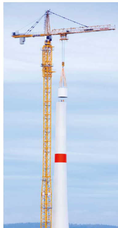
(d) Montage der Segmentringe mittels Turmdrehkran
