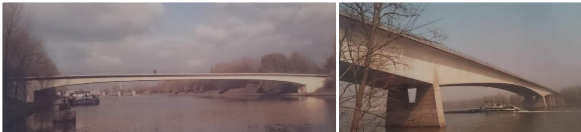
Figure 2.7: left: Neckarkanalbrücke in Heilbronn-Böckingen; right: Rhine Bridge Bendorf (Leonhardt 1982)
