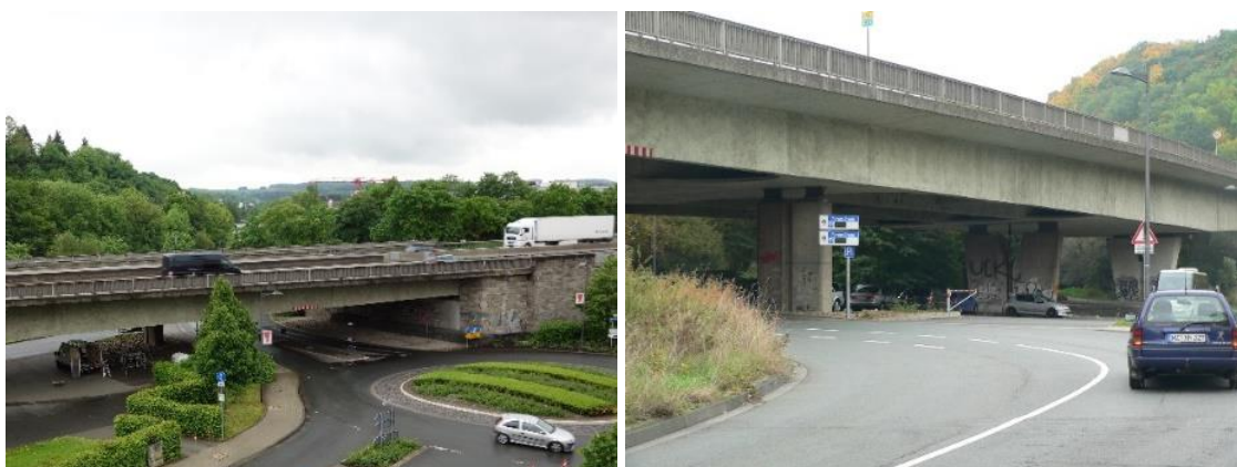
Figure 2.5: left: bridge over Spinnereistraße-Nordseite; right: bridge over Spinnereistraße-Südseite (Bösche & Curbach 2013a)
