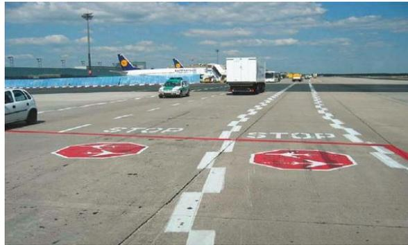
Abbildung 40: Fahrstraßen-Halt(eort)markierung [23]
