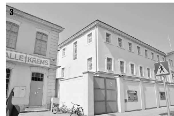
65 | KUNSTHALLE U. ZELLETRAKT 2 MIT AUSBRUCHSSICHERER MAUER
