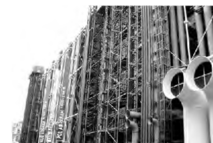
21 | Fassade, sichtbare Haustechnik
