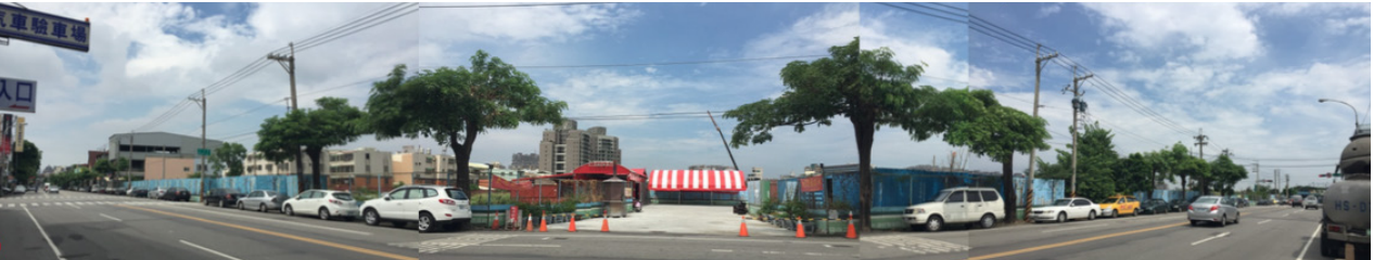
Abb. 37: Ansicht Bauplatz straßenseitig
