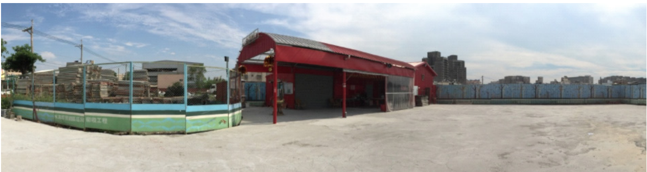
Abb. 36: derzeitiger temporärer Dahe Erdgott Tempel
