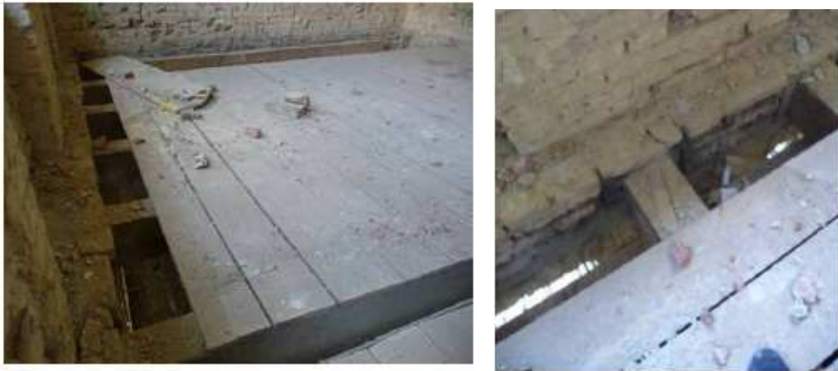
Abb. 75: Deckenfeld mit freigelegten Trämen [13]
