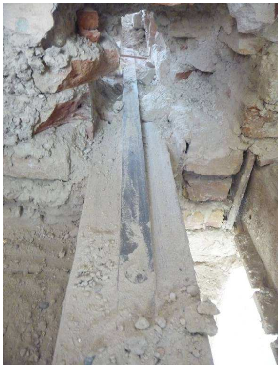
Abb. 90: Freigelegte durchgehende Schließe in der Mittelmauer [15]
