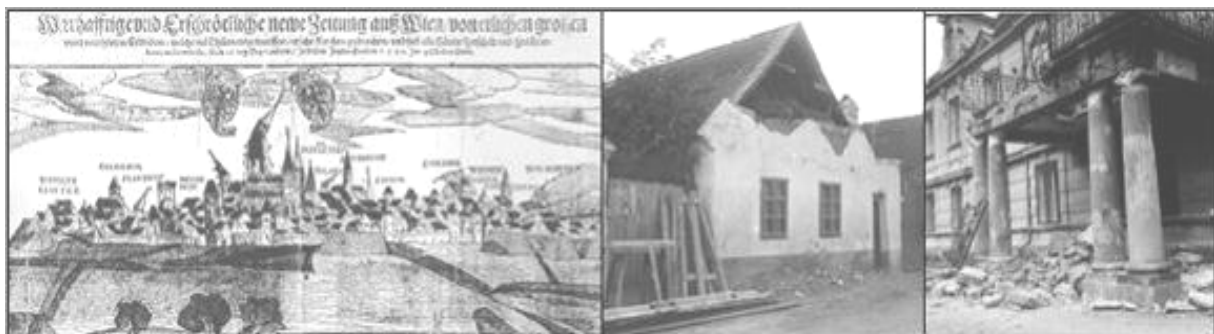
Abb. 7: Starke Bebenschäden in Österreich - 1590 Wien, (Epizentrum Riederberg/NÖ), 1927 Schwadorf und 1972 Seebenstein/Pitten, © ZAMG Geophysik, Ingrid und Wilhelm Milik [27]
