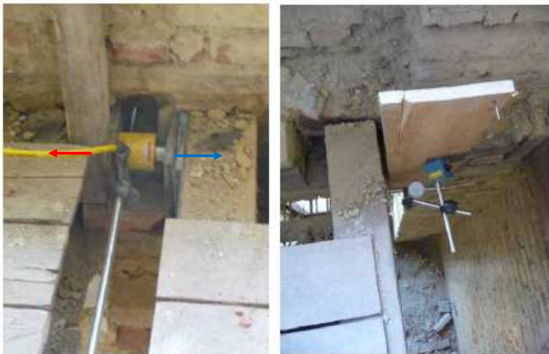
Abb. 76: Kraftpresse- und Messeinrichtung im Deckenfeld [13]
