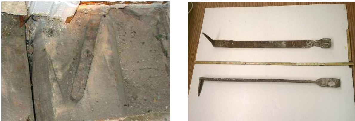
Abb. 19: Eisenschließen
