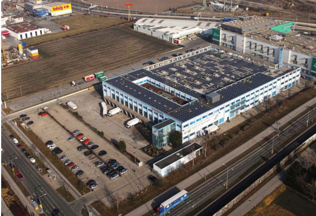
Abb. 10: Luftaufnahme einer Photovoltaikanlage in Wien 22, Quelle: Sunmade
