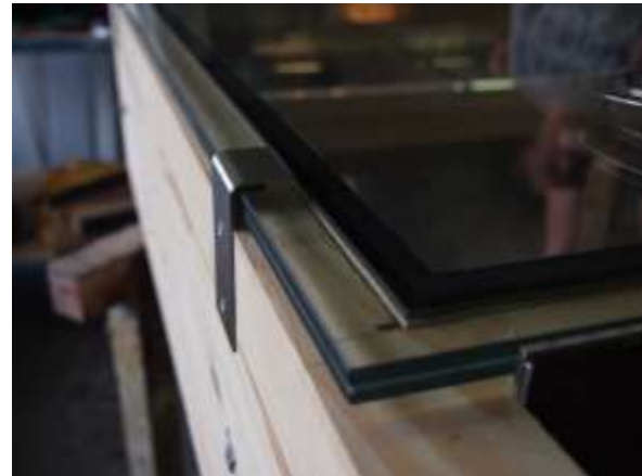
Abb. 5.45: Detailansicht Verklotzung und Haltewinkel [Foto des Autors]
