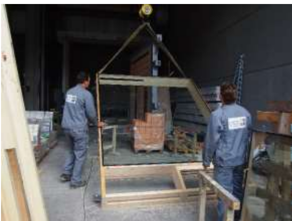
Abb. 5.133: Anheben des verglasten Fassadenelements mit dem Kran [Foto des Autors]
