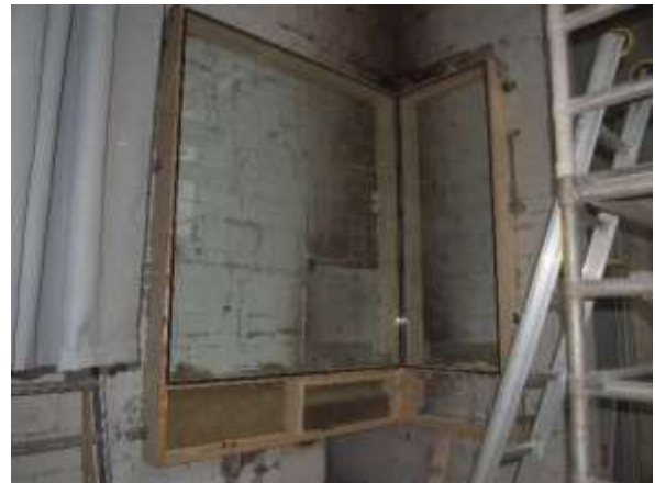
Abb. 5.136: Fassadenelemente vor der Komplettierung [Foto des Autors]
