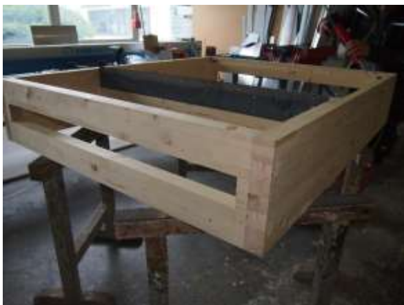
Abb. 5.40: Brettschichtholzrahmen in der Abbundhalle [Foto des Autors]
