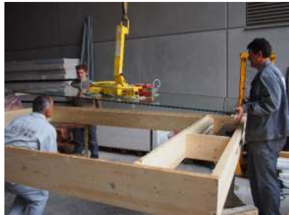
Abb. 5.132: Einheben des HGV-Elements in den BSH-Rahmen [Foto des Autors]
