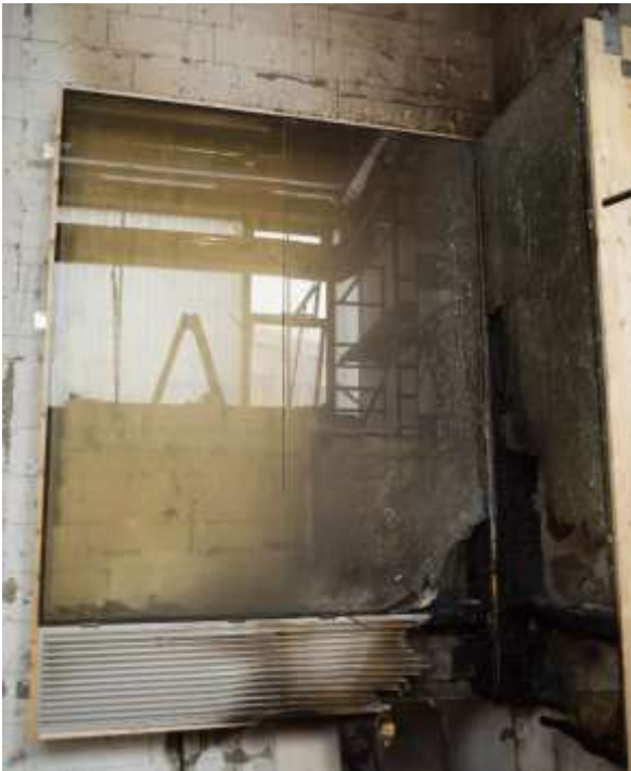
Abb. 5.147: Fassade nach dem Ablöschen [Foto des Autors]
