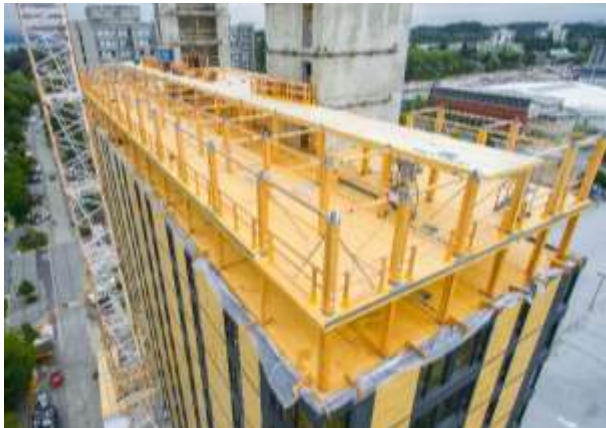
Abb. 7.18 (li.): Bauzustand Brock Commons [W2]
