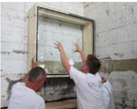
Abb. 5.46: Montage des Probekörpers am Prüfstand [Foto des Autors]
