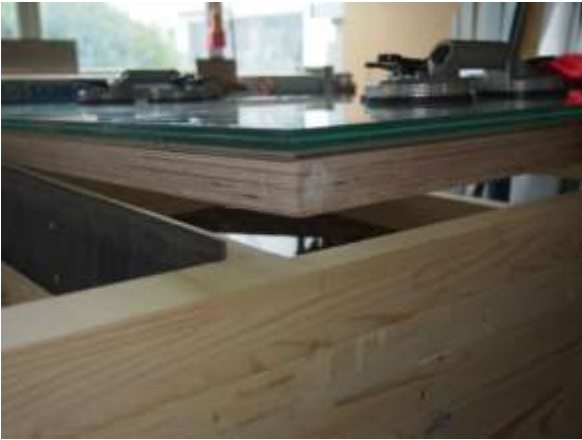
Abb. 5.42: Einsetzen des HGV-Elements in den BSH-Rahmen [Foto des Autors]
