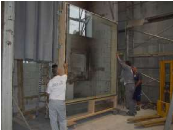
Abb. 5.135: Einrichten des Fassadenelements vor dem Prüfstand [Foto des Autors]
