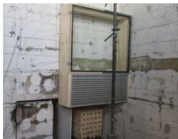
Abb. 5.47: Komplettierung mit Aluminium-Lüftungsgitter [Foto des Autors]
