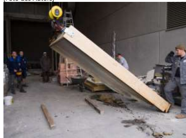
Abb. 5.175: Kippen des Fassadenelements [Foto des Autors]
