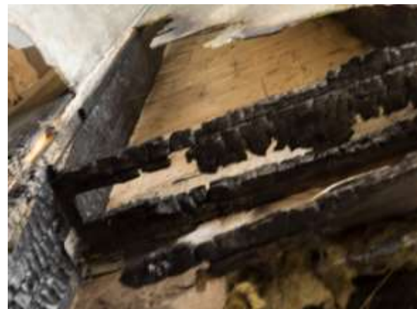
Abb. 5.152: mittlerer Riegel des schmalen Elements [Foto des Autors]
