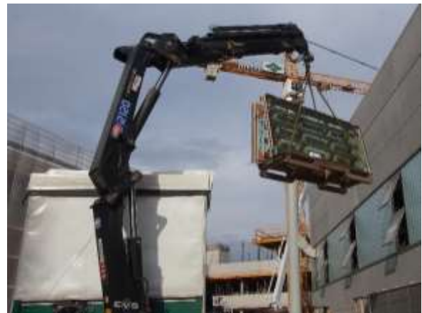
Abb. 5.128: Lieferung der HGV-Elemente [Foto des Autors]
