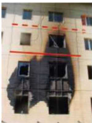
Abb. 3.23 (li.): Unterschiedliche Schutzziele: A: durchgezogene Linie, D/CH: strichlierte Linie [29]
