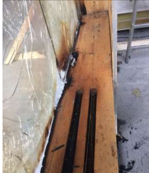
Abb. 5.171: Draufsicht mittlerer Riegel mit Brandsperren [Foto des Autors]
