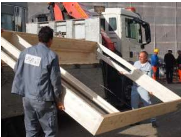
Abb. 5.127: Lieferung der vormontierten BSH-Rahmen [Foto des Autors]
