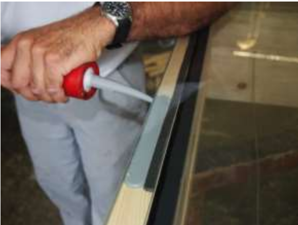
Abb. 5.44: Verfugung der Außenkante mit Brandschutzsilikon [Foto des Autors]
