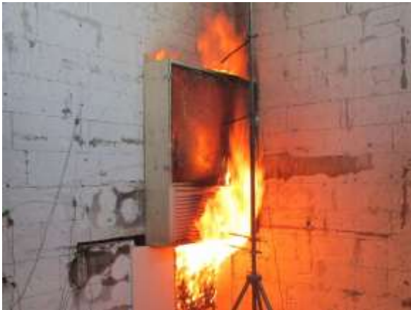
Abb. 5.56: voll entwickelter Brand im Fassadenzwischenraum (10. Minute) [Foto des Autors]
