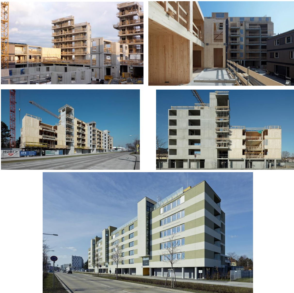
Abbildung 5-8: Bauausführung, Fertigstellung des Wohnbaus Wagramer Straße [76]
