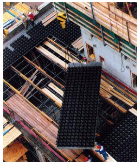
Abbildung 3-16: Deckenkonstruktion aus BubbleDeck, Millenium Tower Rotterdam [42][43]
