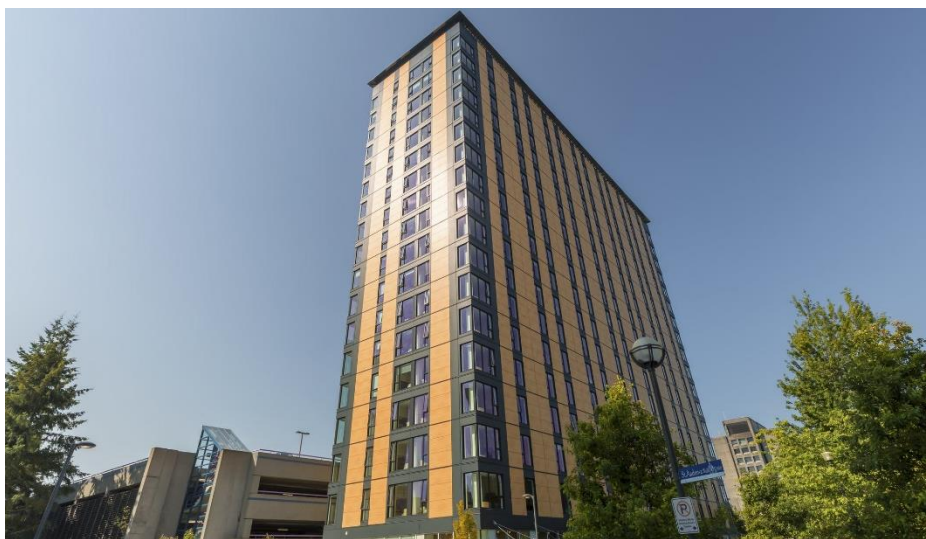
Abbildung 5-21: von Rohbau mit Holztragwerk, Montage der BSH-Deckenplatten, Aufstellen der BSH-Stützen bis zur Fertigstellung des Projektes [89]
