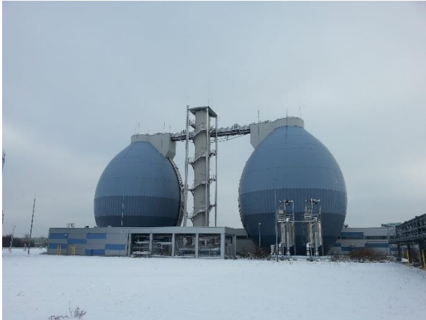
Abbildung 11: Faulbehälter
