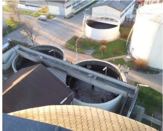
Abbildung 12: offene Vorlagebehälter
