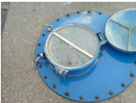
Abbildung 31: Mannloch mit Schauglas und Abdeckung
