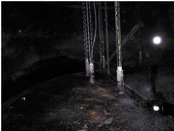
Abbildung 47: Faulraum von Faulbehälter 1, bei einer Revision 2004 nach ca. 20 Jahren Betrieb
