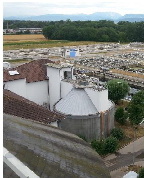
Abbildung 42: Co-Substrat-Vorlagebehälter (1.000 m 3 ) ehemaliger Faulbehälter
