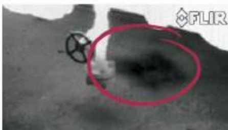
Aufgespürtes Gasleck an einem Produktionsstandort
