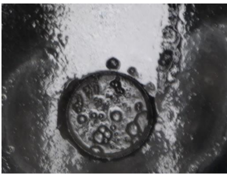
Abbildung 29: Steigrohr im Schlammschacht
