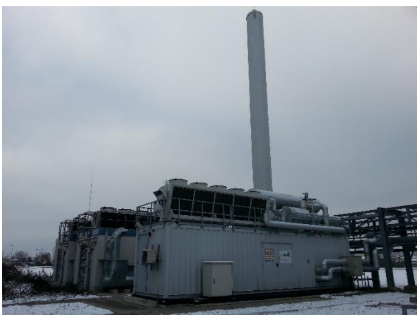
Abbildung 15: Blockheizkraftwerk
